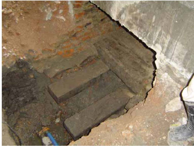
ภาพที่ 2.12 การวางขอนไม้รูปสี่เหลี่ยมจัดวางแบบไม้หมอนรถไฟ
