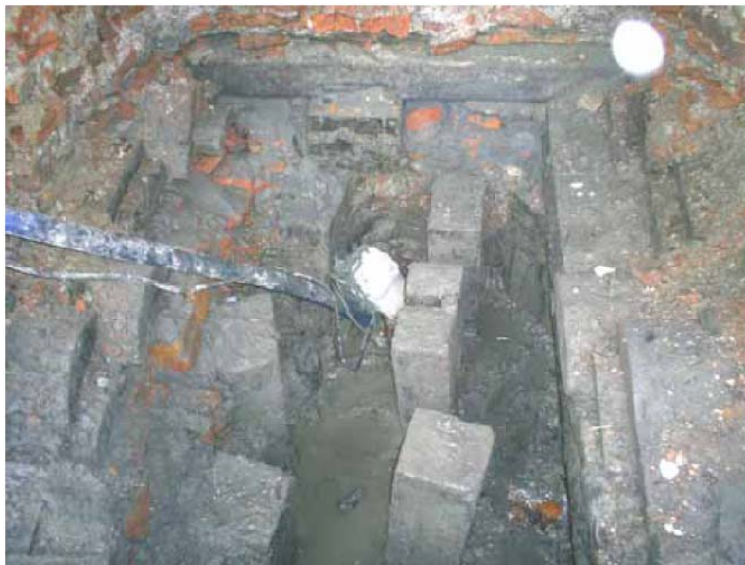
ภาพที่ 2.13 ขอนไม้แต่ละท่อนรองรับด้วยเสาเข็มหน้าตัดสี่เหลี่ยม จำนวน 4 ต้น
