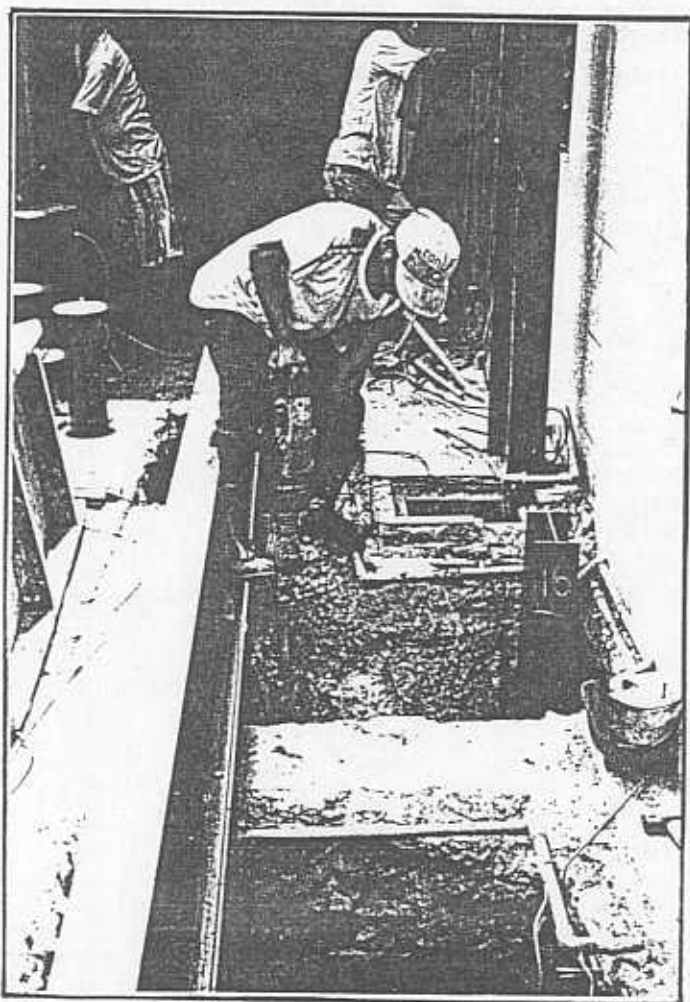
ภาพที่ 4.12 ทำการเจาะพื้นคอนกรีตโดยใช้เครื่องเจาะคอนกรีต
