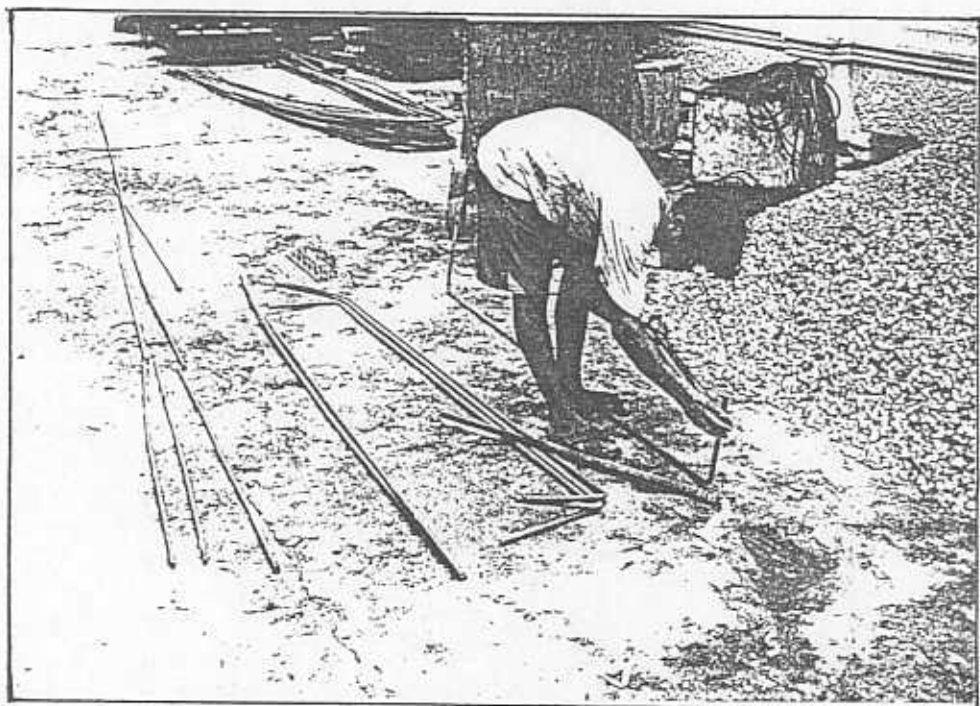
ภาพที่ 4.21 ขณะเตรียมเหล็กเสริมเพื่อทำฐานรากใหม่
