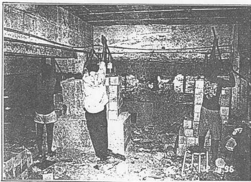
ภาพที่ 4.47 คนงานกำลังรอสัญญาณเสียงในระหว่างทำการขุดโดยใช้แม่แรงไฮดรอลิก
