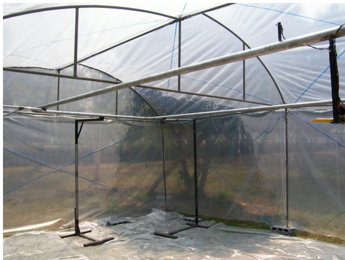
ภาพที่ 43 รางวิ่งที่ติดตั้งในโรงเรือน
