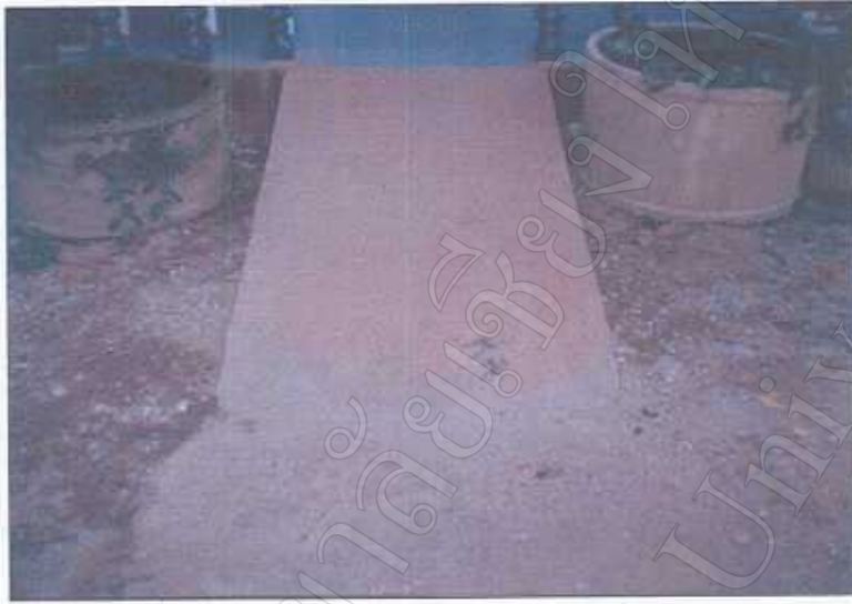
รูปที่ 1 แสดงภาพทางลาดสำหรับขึ้นบ้านที่ปรับสำหรับคนพิการ
