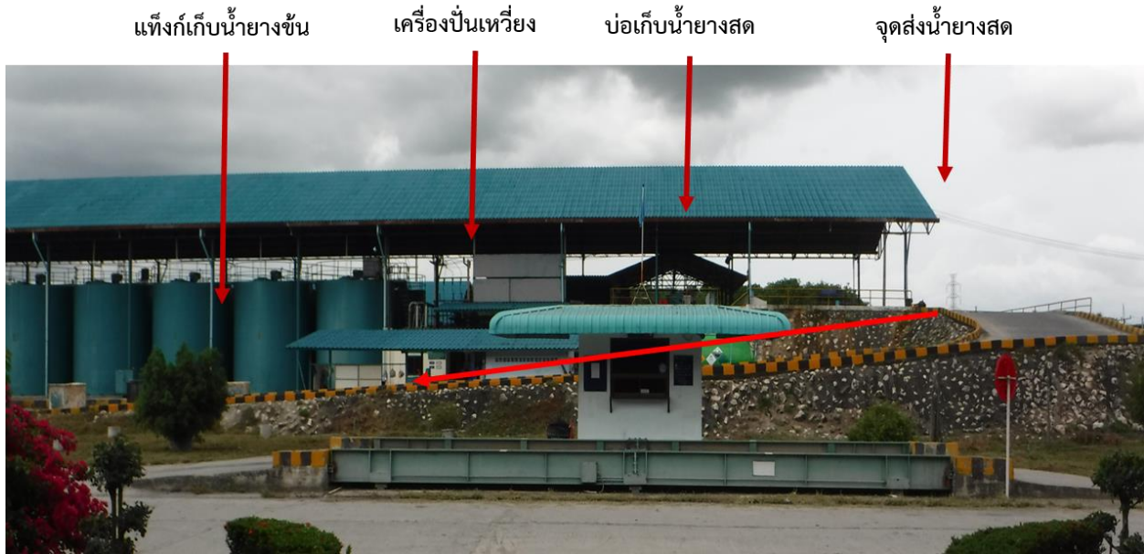
รูปที่ 4 ลักษณะที่ตั้งของโรงงานผลิตน้ำอย่างชัน
