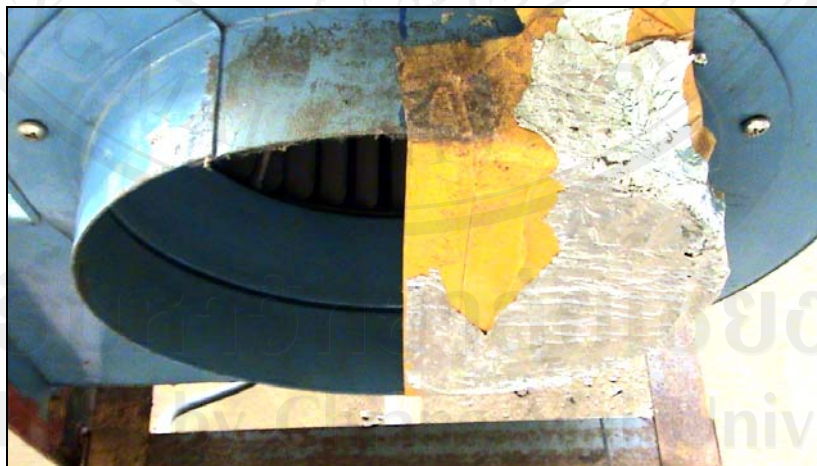
รูปที่ 3.11 ลักษณะการปิดช่องลมทางเข้าของพัดลมส่งอากาศ
