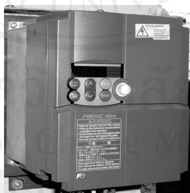
รูป ก 9 อินเวอร์เตอร์ ขนาด 3.75 kW (5 แรงม้า)
