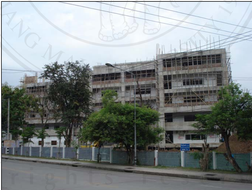
รูป ง-2 ด้านข้างโครงการก่อสร้างอาคารเรียนและปฏิบัติการ 5 ชั้น คณะศึกษาศาสตร์ มหาวิทยาลัยเชียงใหม่
