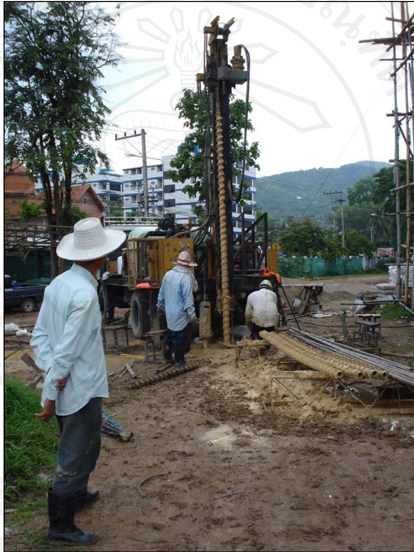
รูป ง-5 เจาะสำรวจดินและทดสอบในสนาม
