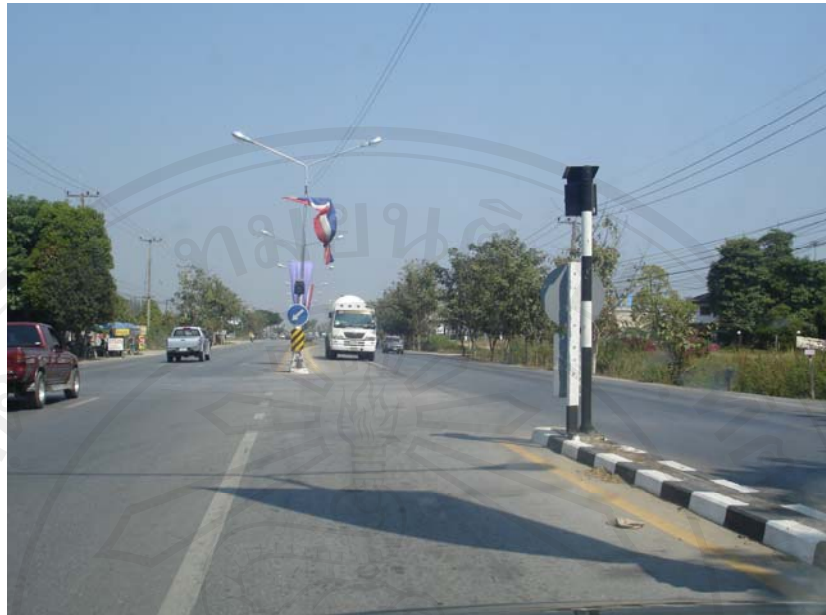
รูป 3.6 ถนนสายเชียงใหม่-แม่โจ้สร้างเสร็จสมบูรณ์
