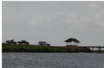
ภาพที่ 25 : ถนนที่สร้างใหม่บริเวณคลองนางเรียม
