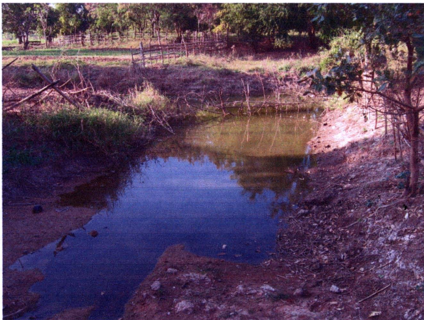
รูปที่ 3-4 ระบบบำบัดน้ำเสียบ่อปรับเสถียรบ่อ 5
