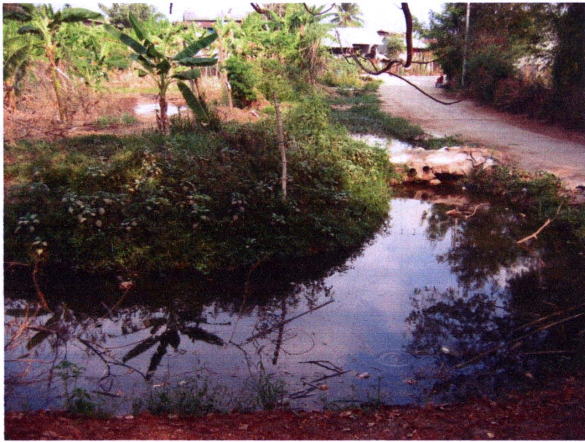
รูปที่ 3-3 ระบบบำบัดน้ำเสียชุมชนขนาดเล็กบ่อปรับเสถียรบ่อ 1 ถึง บ่อ 4
