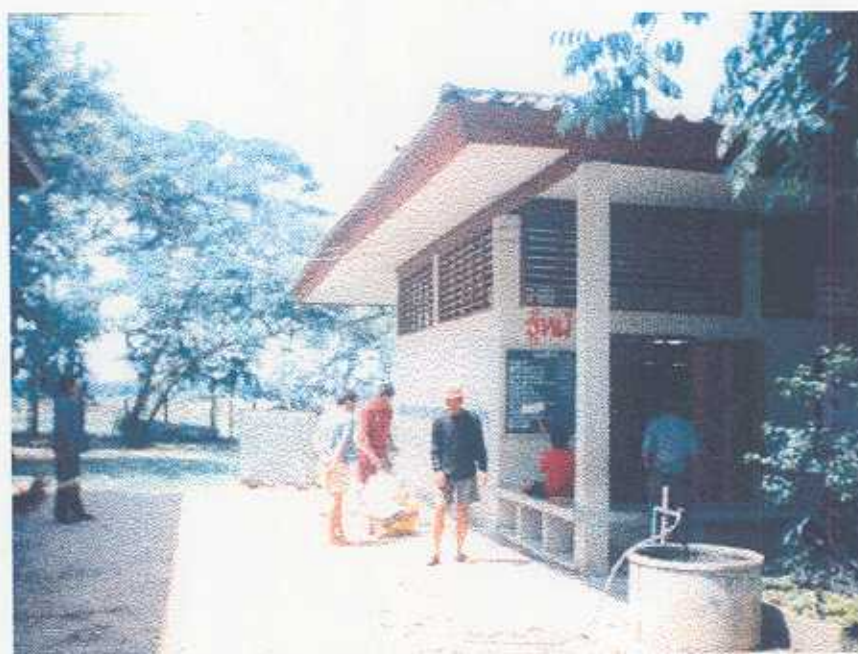
รูปภาพที่ 24 ครู ผู้ปกครองนักเรียน กรรมการโรงเรียนของโรงเรียน ข. กำลัง ดำเนินการปรับปรุงอาคารเรียนแบบ ป.1 ก.
