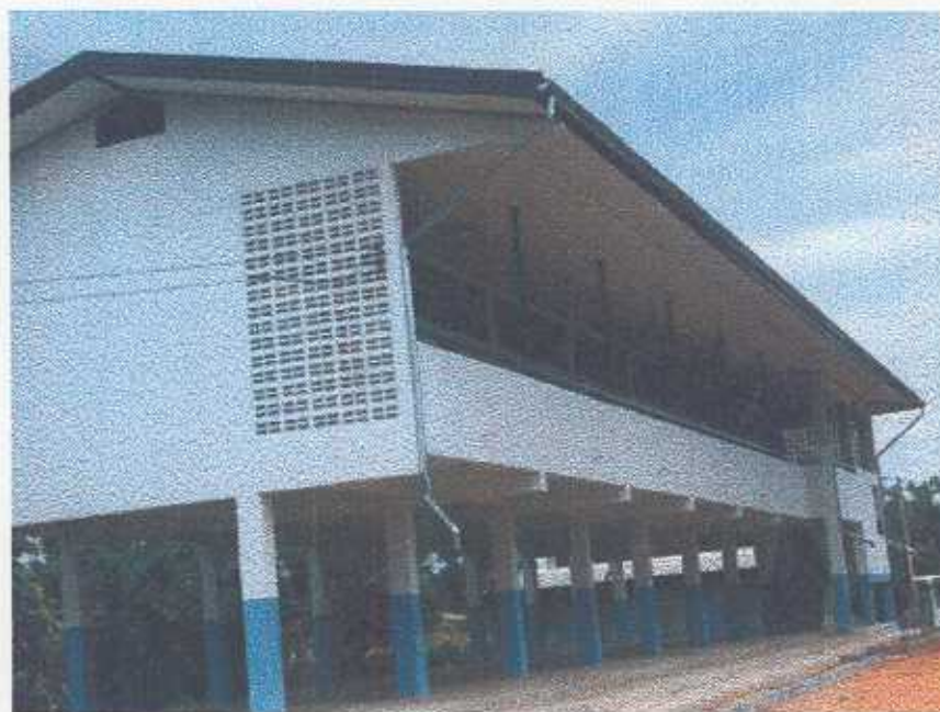
รูปภาพที่ 11 อาคารเรียนแบบ สปช. 105/29 ขนาด 4 ห้องเรียนที่สร้างใหม่ของโรงเรียน ก.
