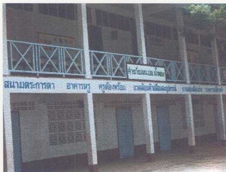
รูปภาพที่ 12 อาคารเรียนแบบ ป.1 ขนาด 12ห้องเรียนของโรงเรียน ก. หลังจากดำเนินการปฏิรูปโรงเรียนและสถานศึกษา
