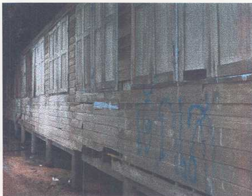
รูปภาพที่ 1 สภาพอาคารเรียนแบบ ป.1. ข ขนาด 7 ห้องเรียนที่ชำรุดทรุดโทรมของโรงเรียน ก.
