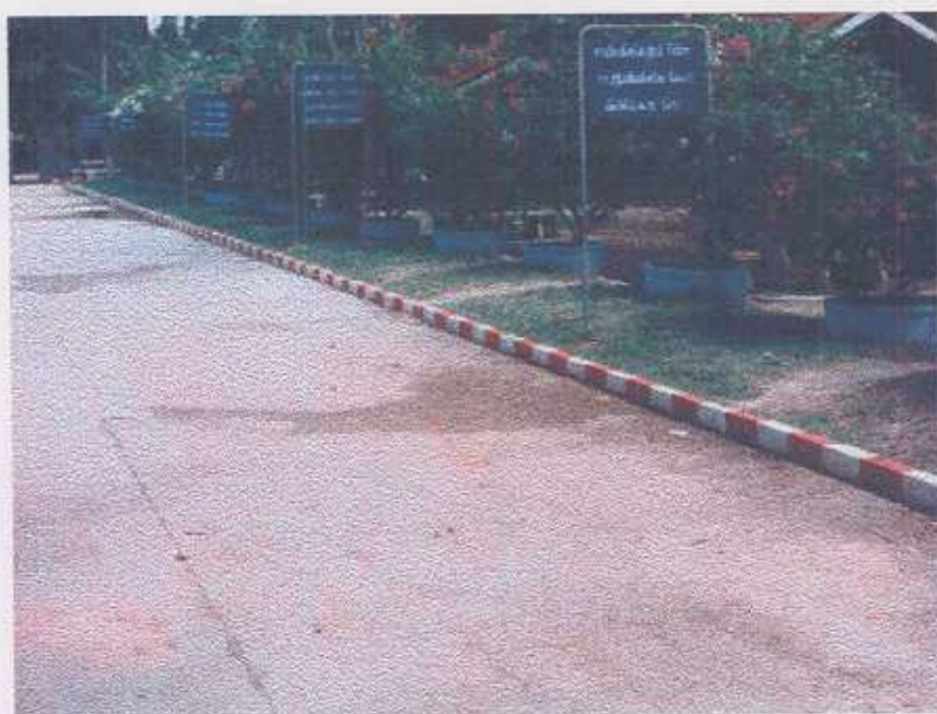
รูปภาพที่ 14 สภาพถนนภายในโรงเรียน ก. ที่ได้รับการปรับปรุงเป็นถนน คอนกรีตเสริมเหล็ก
