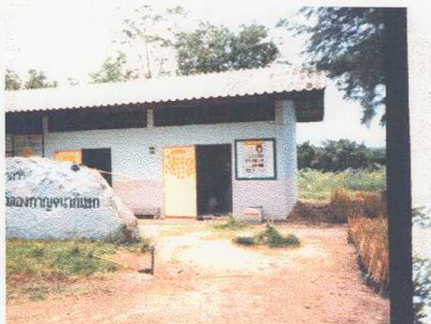
รูปภาพที่ 42 อาคารเรียนที่ก่อสร้างใหม่จากเงินบริจาค ขนาด 2 ห้องเรียน ของโรงเรียน ค.
