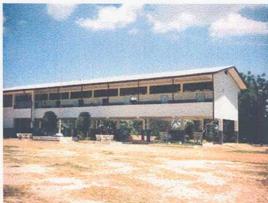
รูปภาพที่ 30 อาคารเรียนแบบ สปช. 105/29 ขนาด 4 ห้องเรียนของโรงเรียน ข. ที่ได้รับงบประมาณสร้างใหม่ สร้างใหม่
