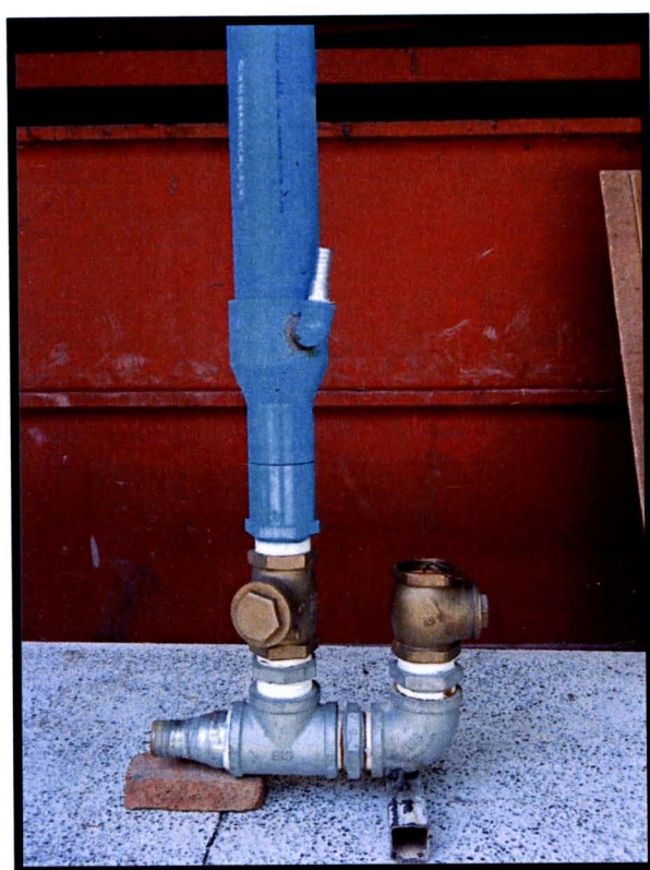
ภาพที่ 2.12 เครื่องสูบน้ำพลังน้ำ(Hydraulic Ram)
