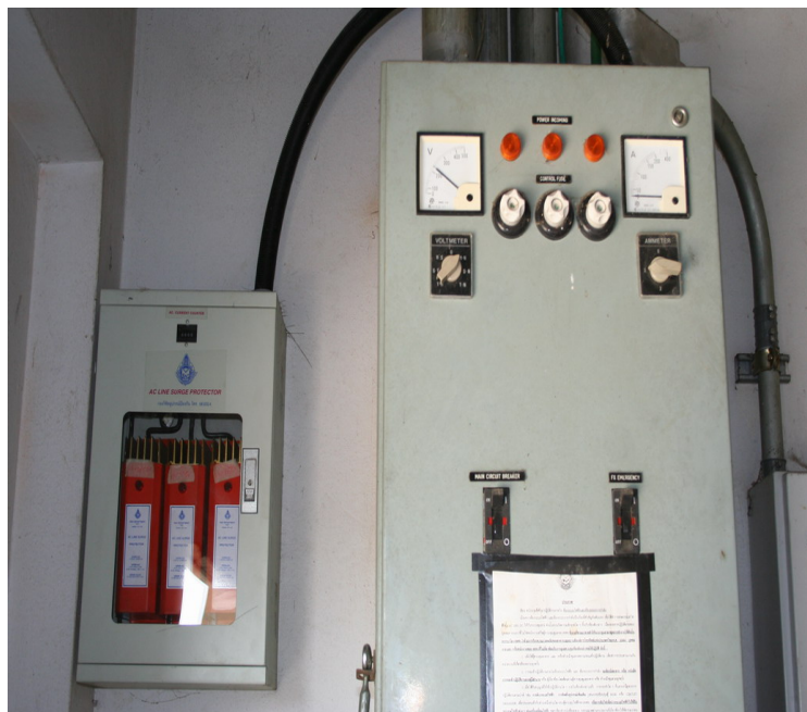
ภาพที่ 58 AC Surge ที่ติดตั้งใช้งานที่สถานีโทรคมนาคม แบบที่2
