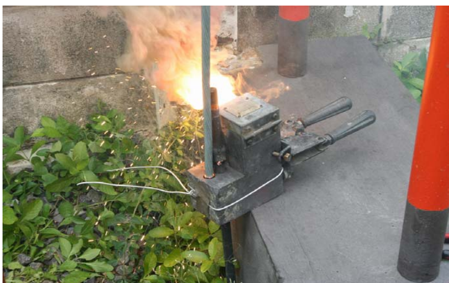
ภาพผนวกที่ 18 การเชื่อมต่อ Air Terminal ของยอดเสา
