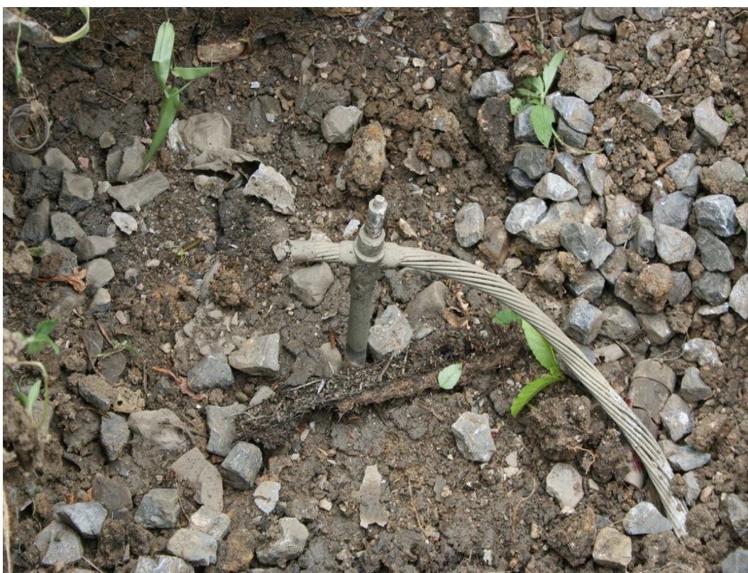
ภาพผนวกที่ 14 การเชื่อมต่อหลักกราวนด์
