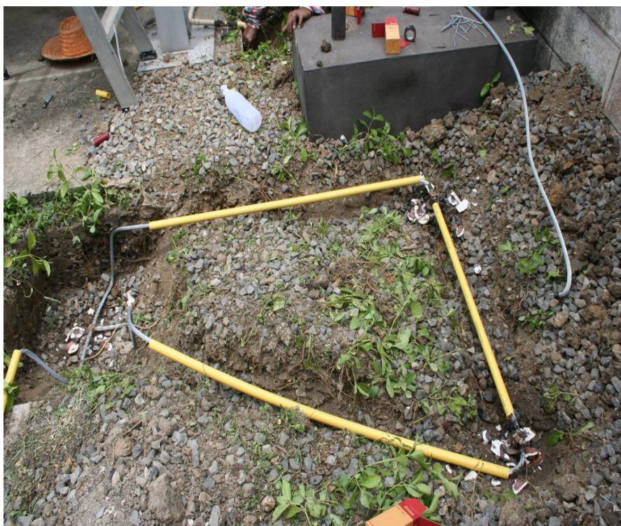
ภาพผนวกที่ 20 การเชื่อมต่อกราวนด์เป็นรูปสามเหลี่ยม
