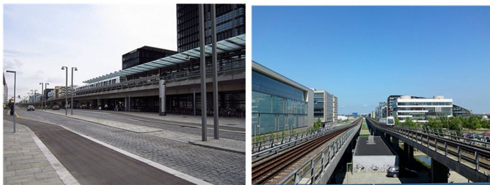
รูปที่ 2.21 ระบบขนส่งสาธารณะ (Metro Line) ที่เชื่อมต่อ Orestad กับส่วนอื่นๆของ Copenhagen
