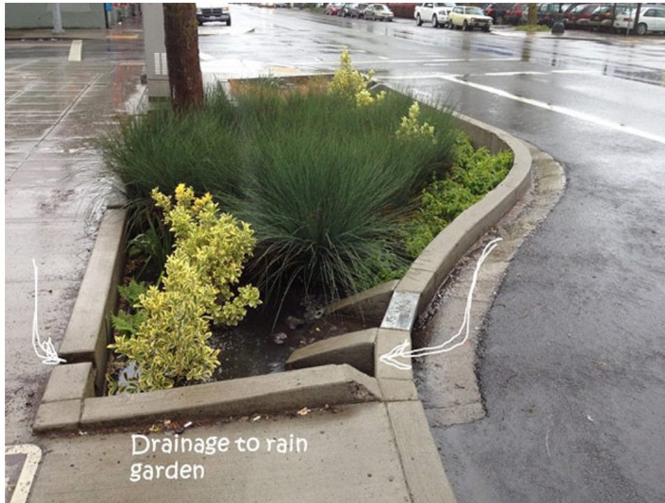
รูปที่ 2.10 ประสิทธิภาพการระบายน้ำฝน ไม่ให้น้ำท่วมขังผิวทางและทางเท้า
