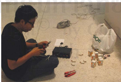
ภาพประกอบ 60 ประกอบขั้วไฟเข้ากับดวงไฟและปลั๊กไฟ
