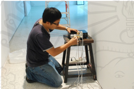
ภาพประกอบ 61 เดินสายไฟและติดตั้งดวงไฟตามจุดที่กำหนดไว้ ต่อปลั๊กเข้ากับเครื่องควบคุมไฟ ปรับความสว่างของแสงและปรับจังหวะของแสงไฟจากเครื่องควบคุมไฟ
