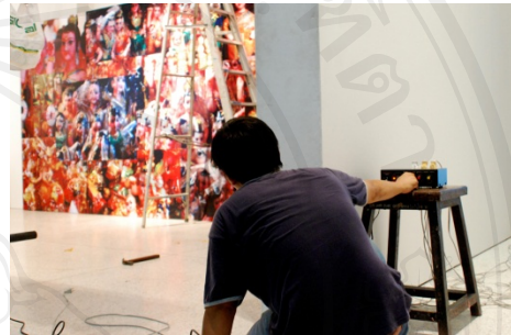
ภาพประกอบ 61 เดินสายไฟและติดตั้งดวงไฟตามจุดที่กำหนดไว้ ต่อปลั๊กเข้ากับเครื่องควบคุมไฟ ปรับความสว่างของแสงและปรับจังหวะของแสงไฟจากเครื่องควบคุมไฟ
