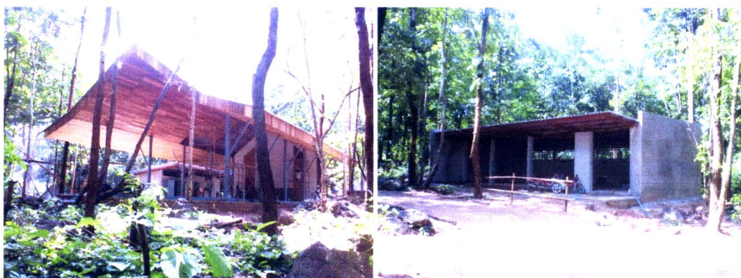
ภาพที่ 5.3 อาคารธรรมศาลา และอาคารนิทรรศการ ยังอยู่ระหว่างกระบวนการก่อสร้าง
