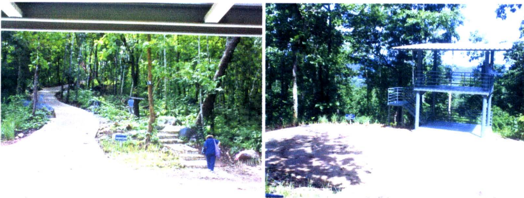
ภาพที่ 5.1 ลานจอดรถ ทางเดินเข้าสู่โครงการ และหอชมยอดไม้ที่ได้ทำการก่อสร้างเสร็จสิ้นแล้ว
