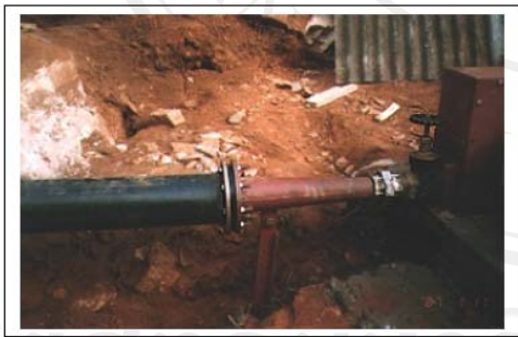
รูป 11-10 การเชื่อมต่อท่อส่งน้ำโดยใช้ flanges
