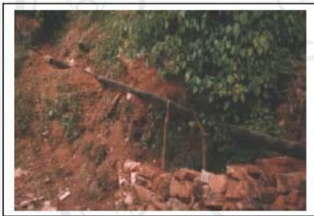
รูป 11-5 ส่วนของท่อที่มีช่องว่างกว้างจะต้องใช้อุปกรณ์เสริมในเรื่องความสูงให้ถูกต้อง ท่อที่ขนาดเส้นผ่าศูนย์กลางมากกว่า 75 มม. ต้องการอุปกรณ์เสริมที่มีขนาดเล็กกว่า เริ่มจาก กิ่งไม้ที่ใช้ในการช่วยในการทำสะพานในพื้นที่ที่ยาก
