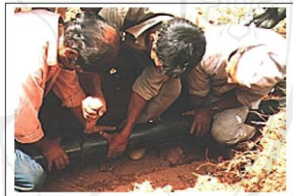
รูป 11-8 ด้านข้างทั้งคู่ของท่อถูกยึดด้วยงานร้อน ด้านท้ายของท่อทั้งสองด้านจะถูกแทรกเข้าไปติดระหว่างด้วยยึดจับกับงานร้อน จะทำให้พลาสติกนุ่มและถูกยึดติดกันทั้งสองส่วนโดยยึดจับตามแนวความยาวของท่อให้แน่น
