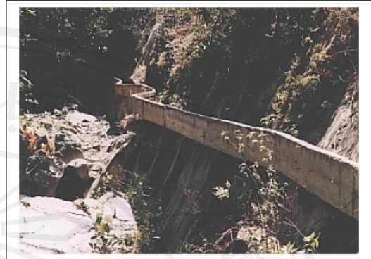
รูป 10-6 ช่องทางน้ำติดตั้งในพื้นที่ลำบากเพื่อใช้ติดตั้งไฟฟ้าพลังน้ำขนาดเล็ก เพื่อผลิตไฟฟ้าให้ชุมชน (เปรู)
