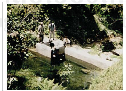
รูป 10-4 ท่อบคอนกรีตถูกใช้เป็นที่เก็บน้ำ(เนปาล)
