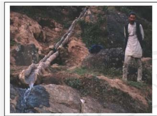
รูป 10-8 ท่อไม้ไผ่ขนส่งน้ำในทางน้ำข้ามพื้นดิน
