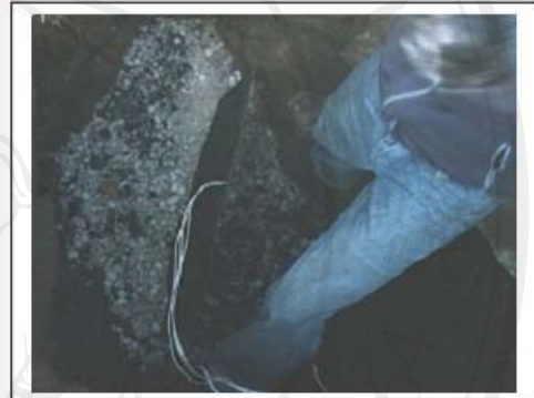
รูป 9-3 การติดตั้งแผ่นทองแดงเป็นแท่งตัวนำลงดินมีสายดินหลายสายถูกใช้เพื่อลดความต้านทาน และเพิ่มความน่าเชื่อถือ (เนปาล)
