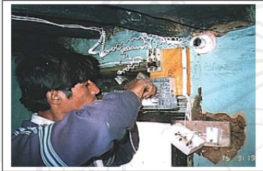
รูป 15-1 การติดตั้งวงจรไฟฟ้าภายในบ้าน
