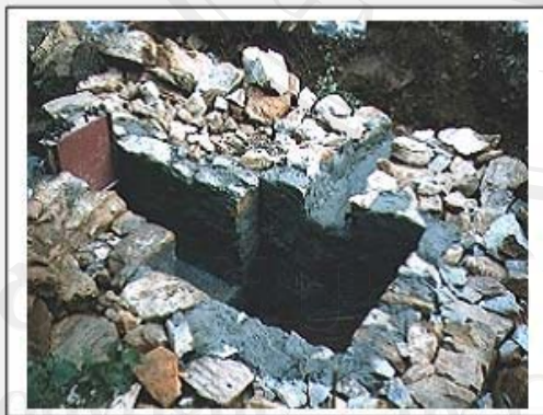
รูป 10-16 การไหลของน้ำเข้าสู่ที่พัก ควบคุมด้วยประตูน้ำ ถ้ามีน้ำมากเกินไปจะส่งไปที่ถังหุบเขา ดังนั้น น้ำที่เกินจะไหลไปสู่แหล่งน้ำโดยที่ไม่มีการทำลายอิฐปูน ท่อระบาย ยึดด้วยแท่งไม้ที่ติดอยู่ที่ส่วนต่ำสุดของถังเก็บพักน้ำ
