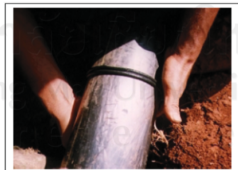
รูป 11-9 งานจะถูกถอนออกและท่อทั้งสองส่วนถูกรวมเป็นอันเดียวกันทำให้มีวงเรียบรอบท่อเกิดขึ้น
