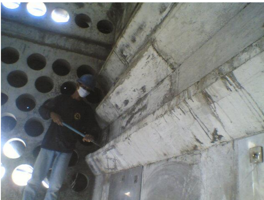
รูปภาคผนวกที่ 2. แสดงการหล่อโมดูล II. ของชิ้นส่วนเตากระทบบความร้อนของ silica refractory แบบ casting type
