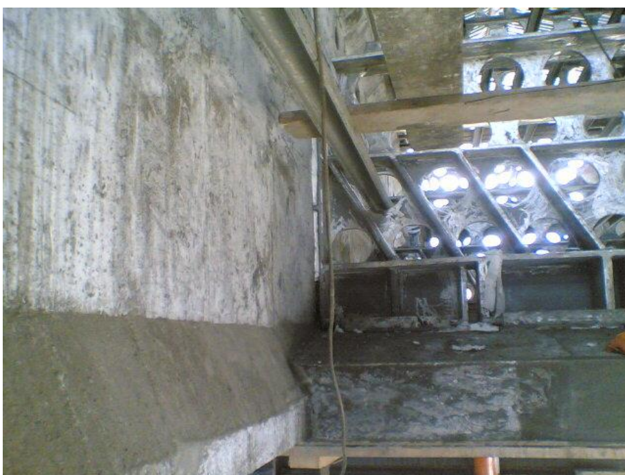
รูปภาคผนวกที่ 4. แสดงการหล่อโมดูล IV. ของชิ้นส่วนเตากระแทกความร้อนของ silica refractory แบบ casting type
