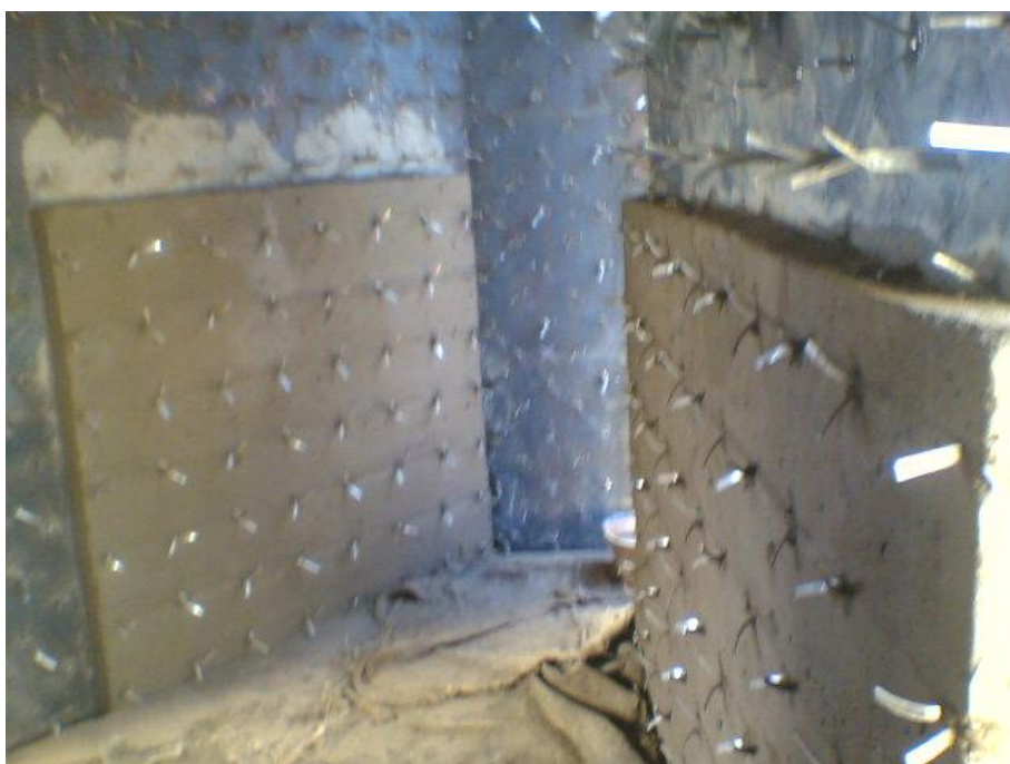
รูปภาคผนวกที่ 6. แสดงการหล่อโมดูลของชิ้นส่วนปล่องควันกระทบความร้อนของ silica refractory แบบ casting type (2)
