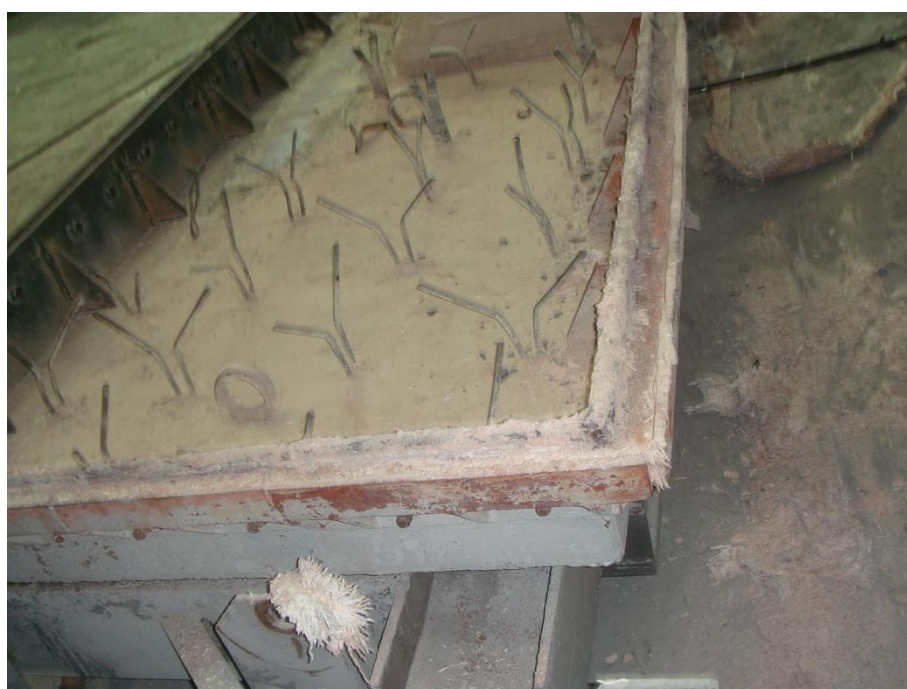
รูปภาคผนวกที่ 10. แสดงการหล่อของชิ้นส่วนกระทบความร้อนเผาหลอมของ silica refractory แบบ casting type (2)
