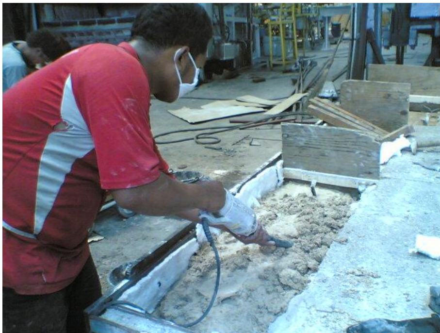
รูปภาคผนวกที่ 9. แสดงการหล่อของชิ้นส่วนกระทบความร้อนเผาหลอมของ silica refractory แบบ casting type (1)
