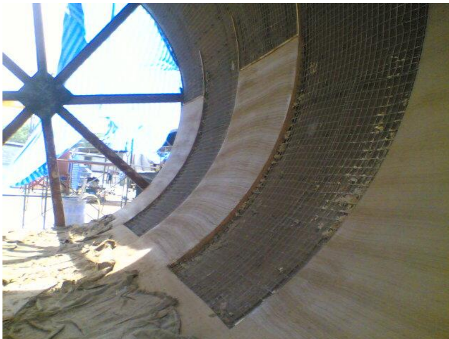
รูปภาคผนวกที่ 7. แสดงการหล่อโมดูลของชิ้นส่วนปล่องควันทะบความร้อนขนาดใหญ่ของ silica refractory แบบ casting type (1)
