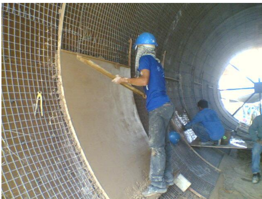
รูปภาคผนวกที่ 8. แสดงการหล่อโมดูลของชิ้นส่วนปล่องควันทะบความร้อนขนาดใหญ่ของ silica refractory แบบ casting type (2)
