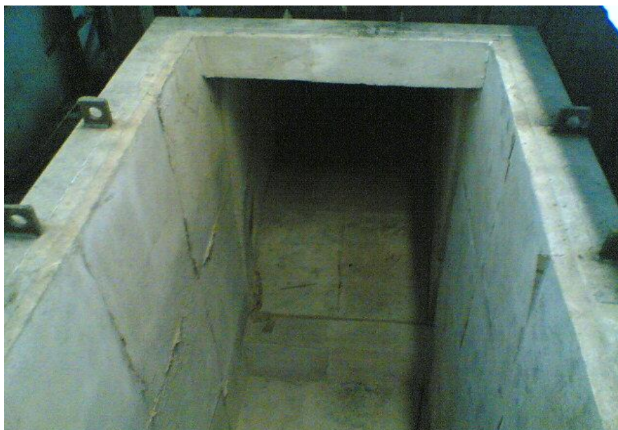
รูปภาคผนวกที่ 18. แสดงการหล่อผนังภายในกระทบความร้อนของ silica refractory แบบ casting type (2)
