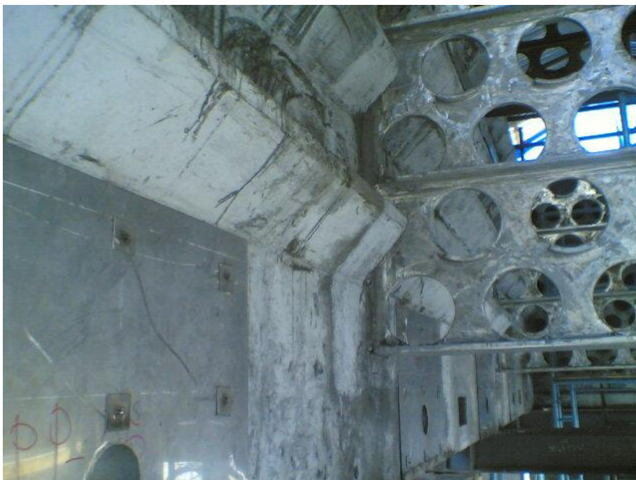
รูปภาคผนวกที่ 3. แสดงการหล่อโมดูล III. ของชิ้นส่วนเตากระแทกความร้อนของ silica refractory แบบ casting type
