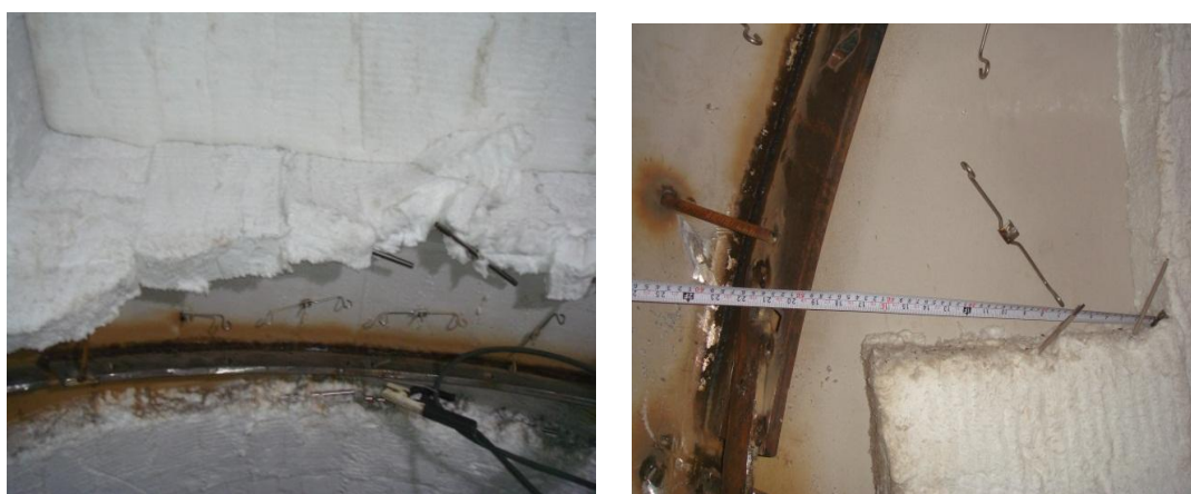
รูปที่ 18. ทำการเตรียมชิ้นส่วนก่อนการขึ้นรูปด้วย Silica refractory
