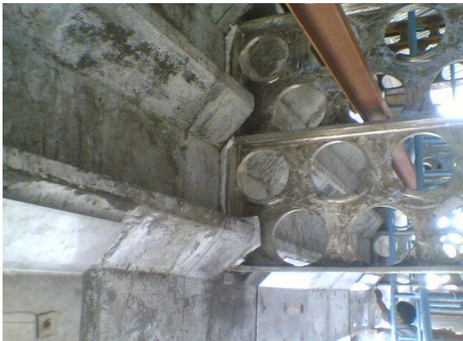
รูปภาคผนวกที่ 7. แสดงการหล่อโมดูล I. ของชิ้นส่วนเตากระทบบความร้อนของ silica refractory แบบ casting type
