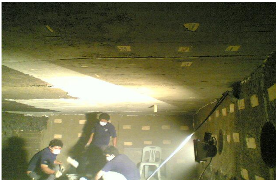
รูปภาคผนวกที่ 17. แสดงการหล่อผนังภายในกระทบความร้อนของ silica refractory แบบ casting type (1)
