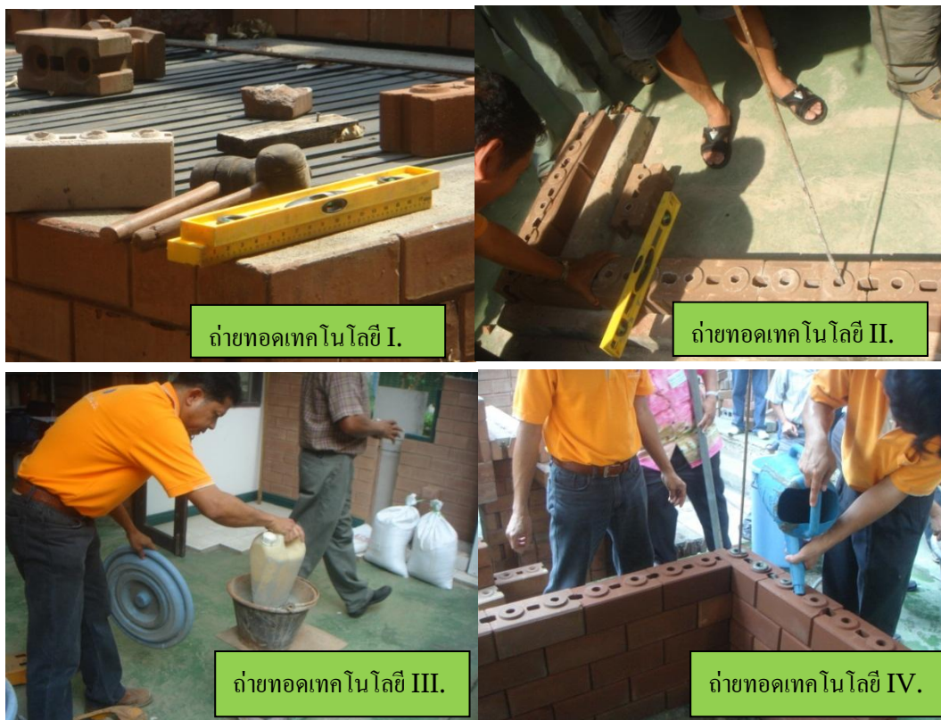
ภาคผนวก 6. แสดงรูปถ่ายทอดงานวิจัยการก่อสร้างอิฐบล็อกประสานโดยใช้วัสดุดินซีเมนต์ผสมเส้นใยคาร์โบไฮเดรต
