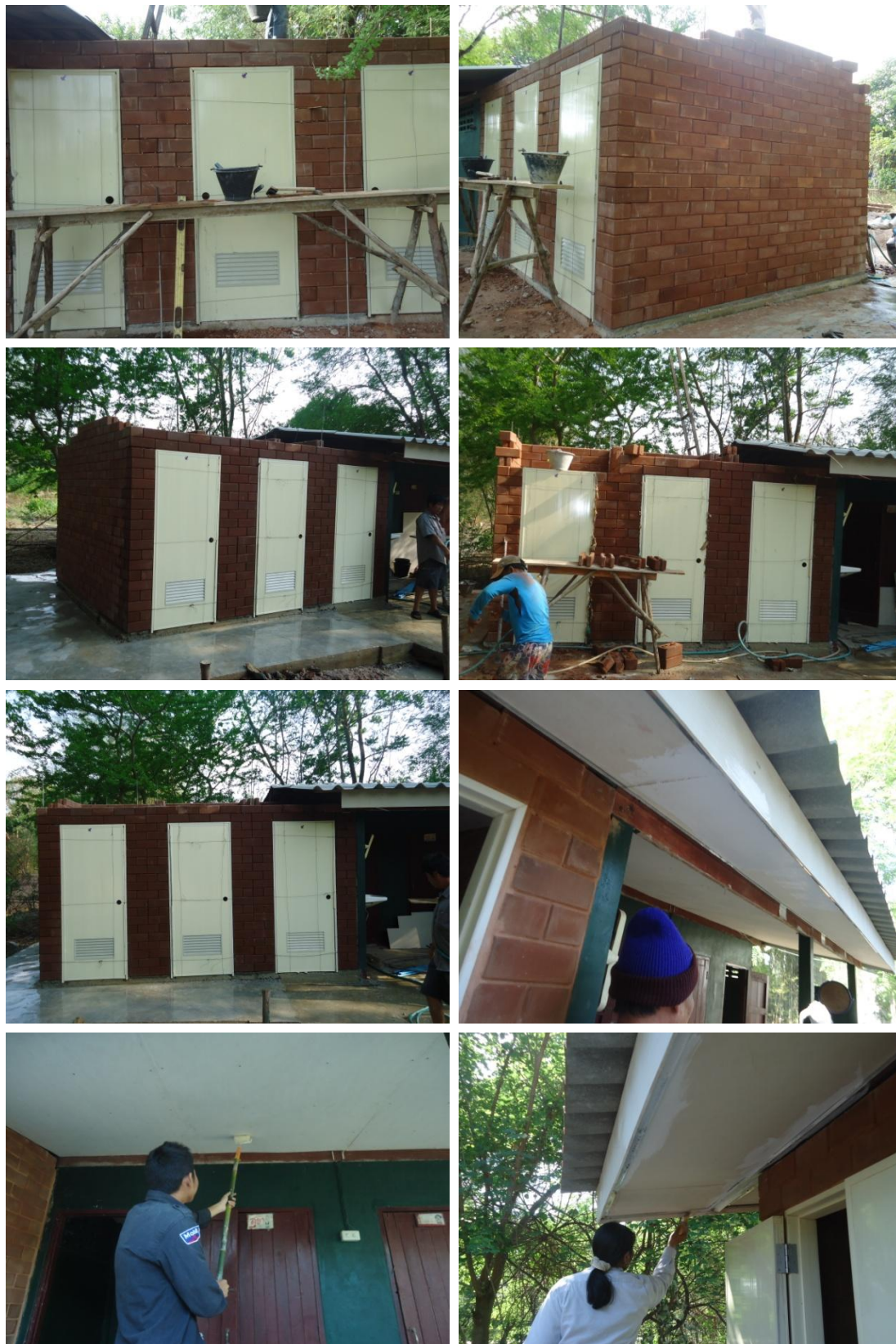
ภาคผนวก 8. แสดงรูปถ่ายทอดงานวิจัยการก่อสร้างอิฐบล็อกประสานโดยใช้อิฐดินซีเมนต์ผสมเส้นใยคาร์โบไฮเดรต (2)
