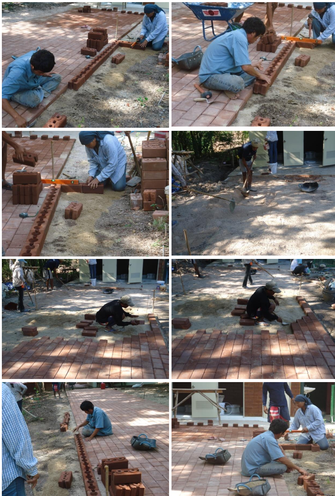
ภาคผนวก 9. แสดงรูปถ่ายทอดงานวิจัยการก่อสร้างอิฐบล็อกประสานโดยใช้อิฐดินซีเมนต์ผสมเส้นใยคาร์โบไฮเดรต (3)
