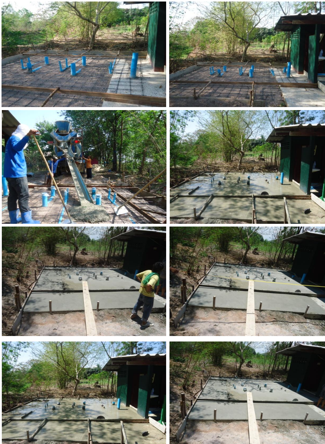
ภาคผนวก 7. แสดงรูปถ่ายทอดงานวิจัยการก่อสร้างอิฐบล็อกประสานโดยใช้อิฐดินซีเมนต์ผสมเส้นใยคาร์โบไฮเดรต (1)
