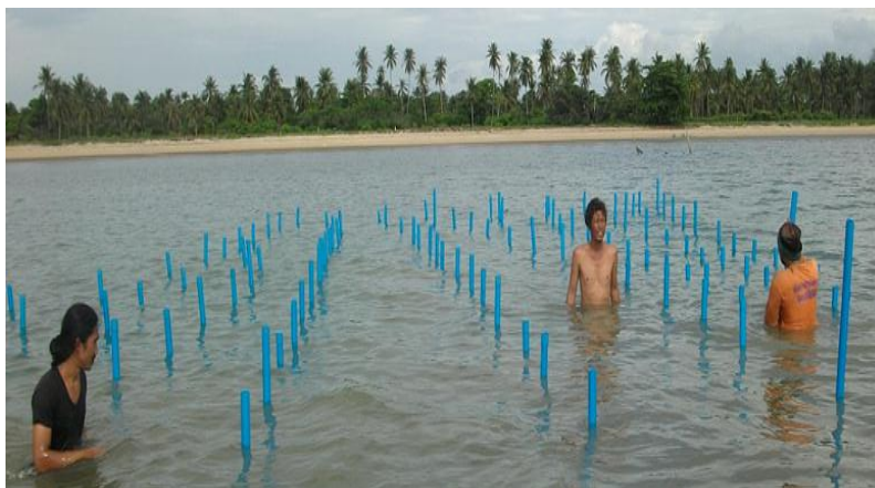
ภาพที่ 6.20 บ้านปลาที่ทำด้วยท่อพีวีซี
