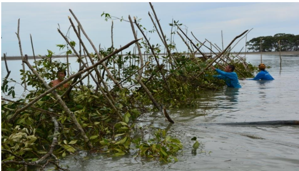
ภาพที่ 6.9 การปักไขว้คร่อมท่อนไม้และกิ่งไม้ไว้ เพื่อไม่ให้ลอยไปกับกระแสน้ำ
