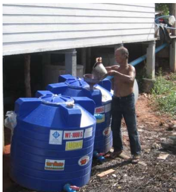
ภาพที่ 6 เป็นภาพการติดตั้งถังหมักขนาด 2000 ลิตร
