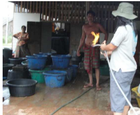
ภาพที่ 8 แสดงการลอยตัวของถังเมื่อเกิดก๊าซชีวภาพและการจุดติดไฟของระบบก๊าซชีวภาพ
