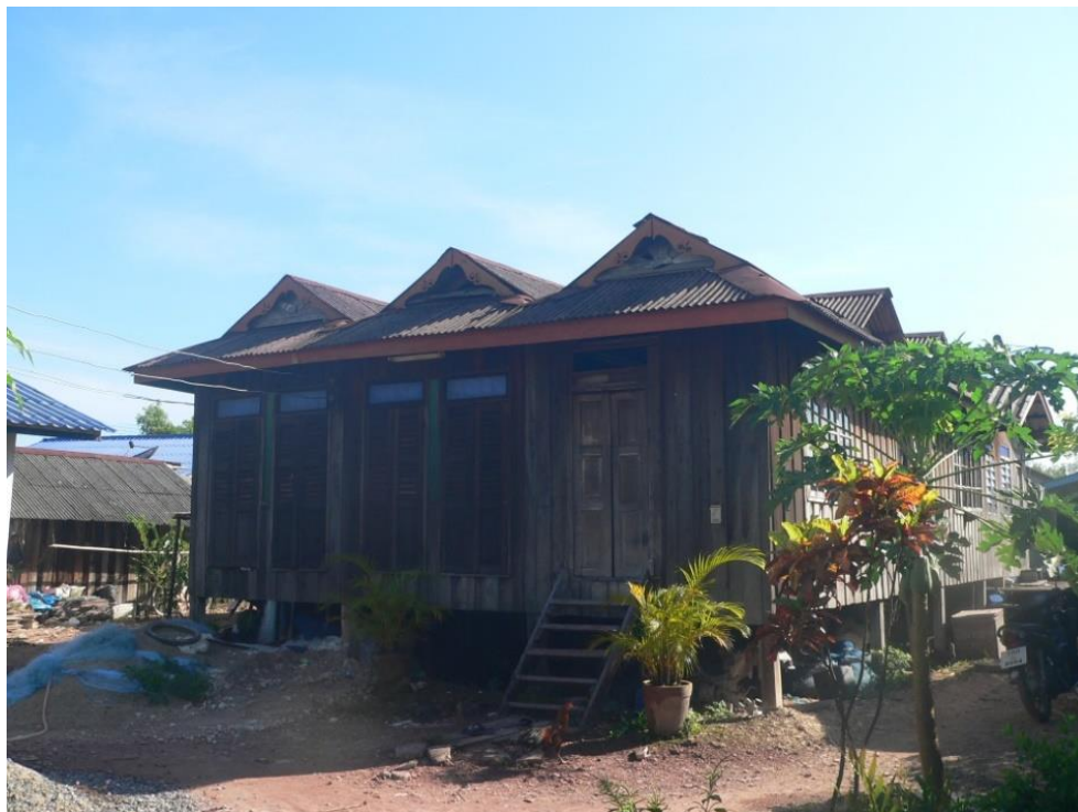
ภาพที่ 4-9 บ้านเรือนที่ตั้งอยู่บนแผ่นดินจะสร้างด้วยไม้แปรรูปเป็นแผ่นๆ (ฝาบ้านแบบแนวตั้ง)
