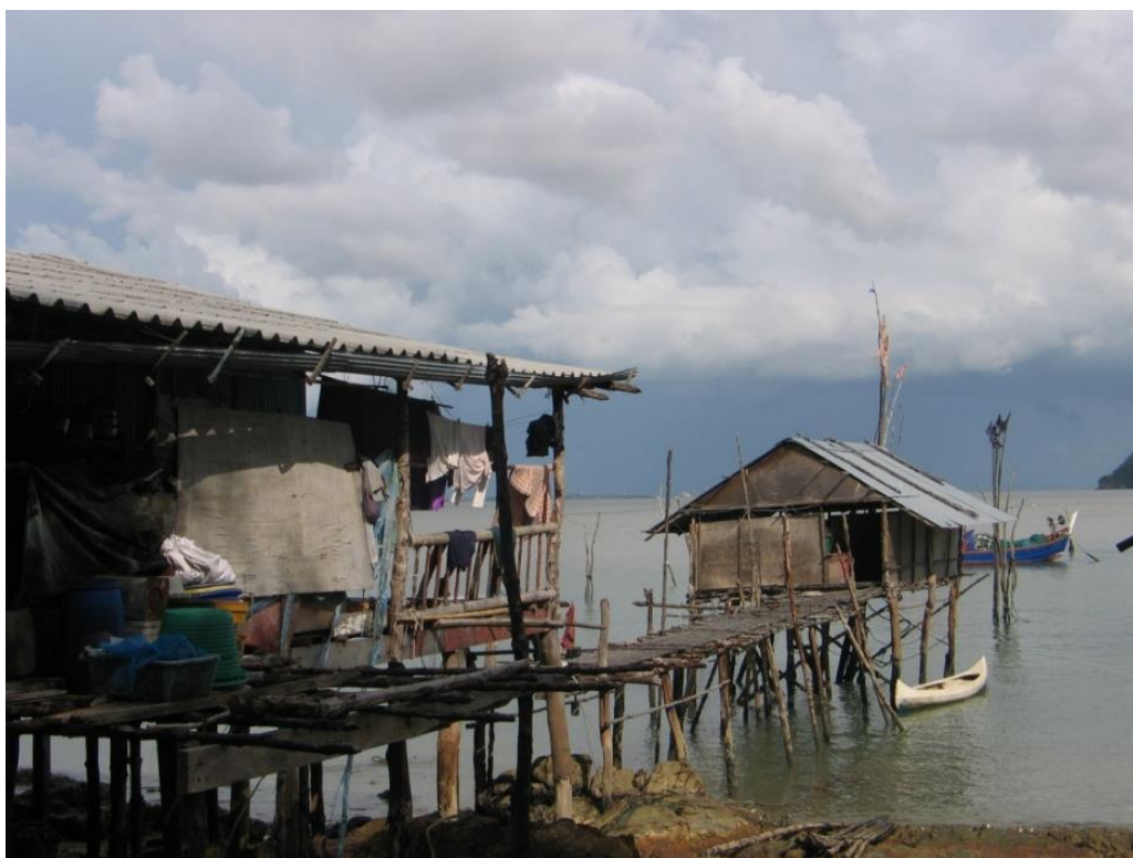
ภาพที่ 4-8 บ้านเรือนที่ตั้งอยู่ในทะเล เสาและพื้นบ้านทำด้วยไม้โกงกาง
