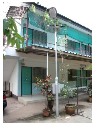
รูปที่ 3.4 โคมไฟ LED และการติดตั้งบนเสาสูง 4 เมตร
