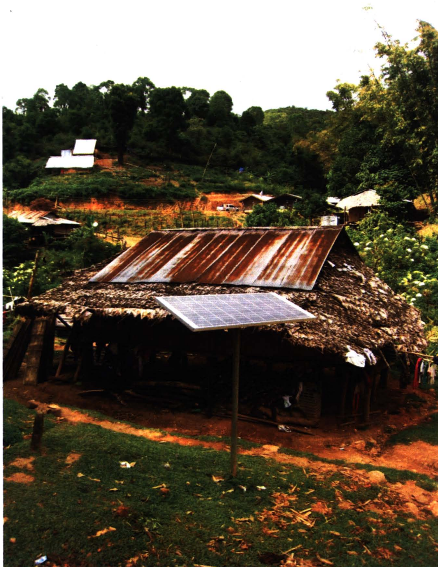
รูปที่ 5-3 แผงพลังงานเซลล์แสงอาทิตย์ ที่กระจายตามแหล่งตามพื้นที่ห่างไกล ซึ่งสอดคล้องกับ และเหมาะสมต่อการนำเอาโคมส่องสว่างนอกตัวอาคารไปติดตั้งร่วม
