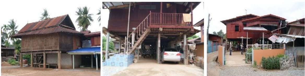
ภาพที่ 4.15-4.17: การผสมผสานวัสดุสมัยใหม่เริ่มปรากฏให้เห็นในการปรับปรุงต่อเติมบ้าน หลังคากระเบื้องลอนคู่ที่ต่อเติมเพิ่มจากเรือนหลังคาปั้นหยาเดิม (ภาพซ้าย) การปูกระเบื้องบริเวณฐานบันได (ภาพกลาง) และกำแพงรั้วปูนที่เปลี่ยนแปลงไปจากลักษณะรั้วเดิมที่นิยมทำจากไม้ไผ่ (ภาพขวา)
