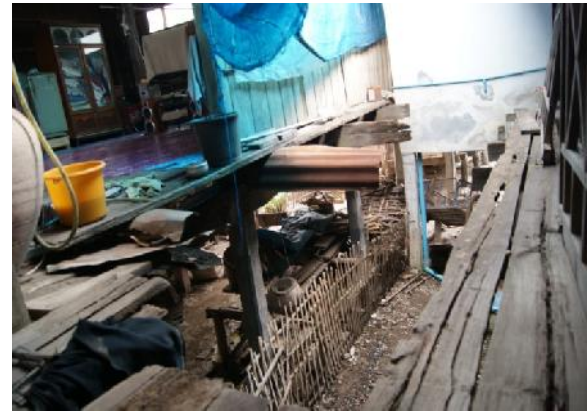
ภาพที่ 4.71-4.72: การเชื่อมต่อเรือนในลักษณะต่างๆ การเชื่อมต่อด้วยแนวผนัง (ภาพซ้าย) ร่องรอยของการเชื่อมต่อด้วยชันพื้น (ภาพขวา)
