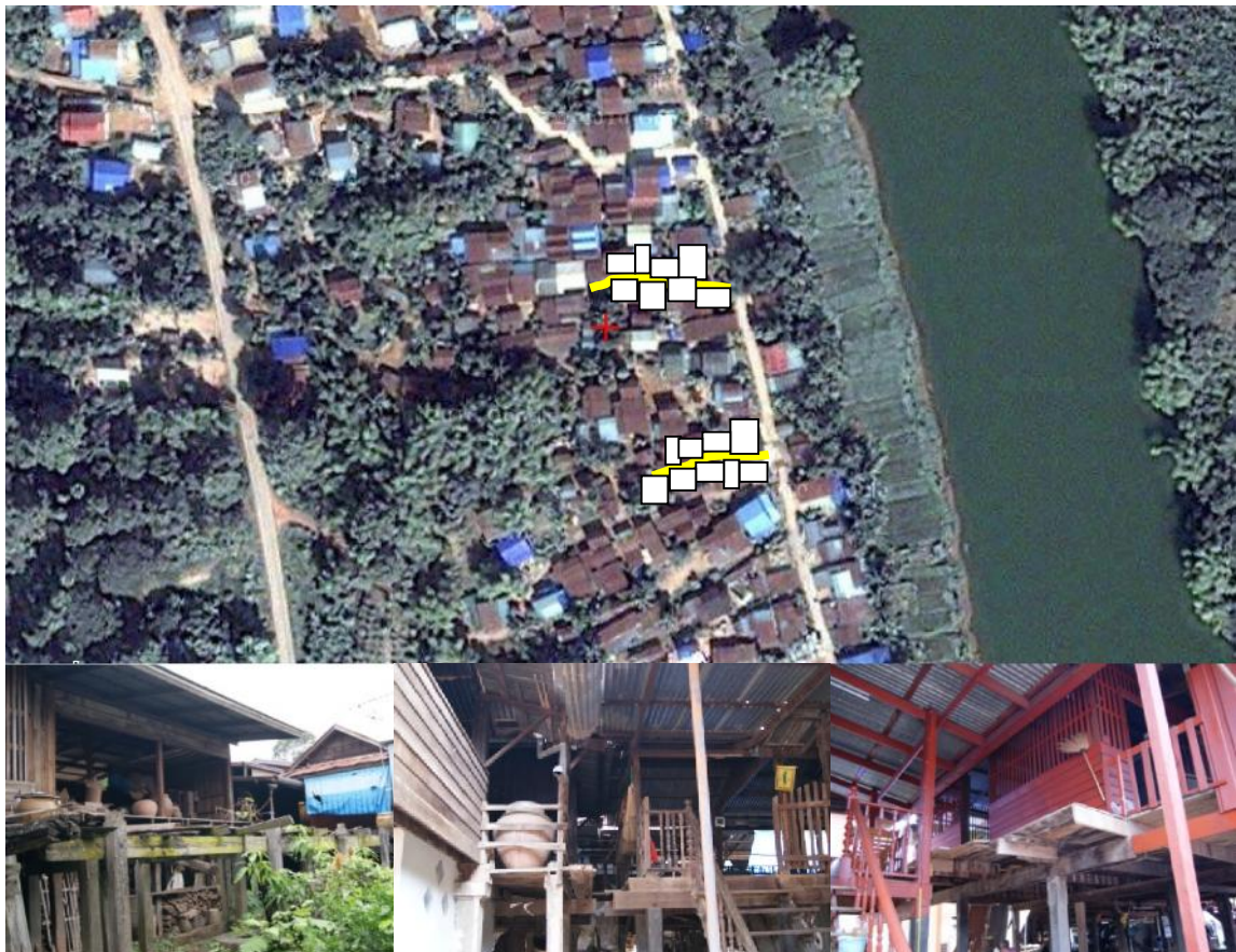
ภาพ (ชุด) ที่ 4.70: การรวมกลุ่มของเรือนลักษณะเป็นพวงสายเชื่อมโยงระหว่างตัวเรือนในกลุ่มเครือญาติ สภาพโครงสร้างที่ผุพังของระเบียงทางเดินที่เคยเชื่อมระหว่างเรือนหน้ากับเรือนที่ต่อเติมเพิ่มตาม แนวตั้งฉากกับแม่น้ำ (ภาพซ้าย) ลักษณะการต่อเชื่อมระหว่างเรือน โดยต่อพื้นเป็นแนวเดิมกับเรือนเก่า และเชื่อมกับบันไดทางขึ้นเรือนใหม่ (ภาพกลาง และภาพซ้าย)
