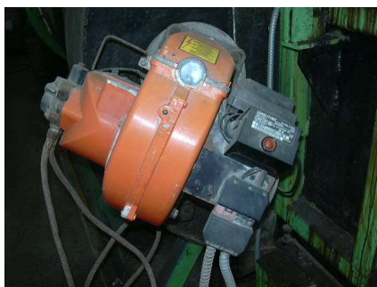
ภาพที่ 21 หัวเผาระบบฉีดน้ำมัน
