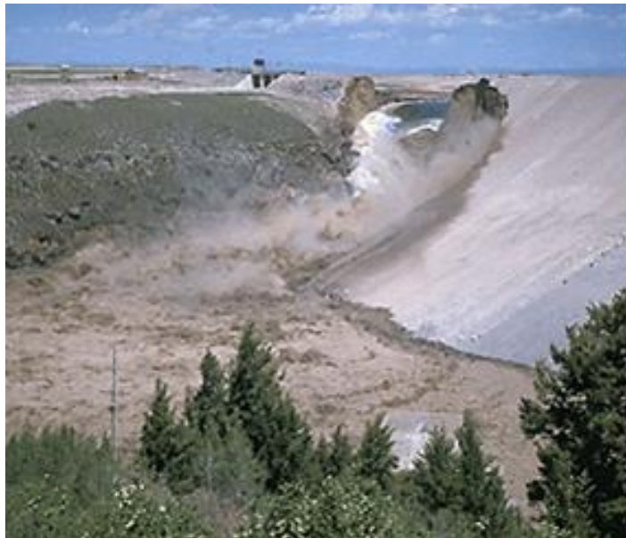
ภาพที่ 1 การพัดของเขื่อน TETON เนื่องจากการรั่วซึมของน้ำผ่านชั้นฐานราก ที่มา: วรากร (2546)
