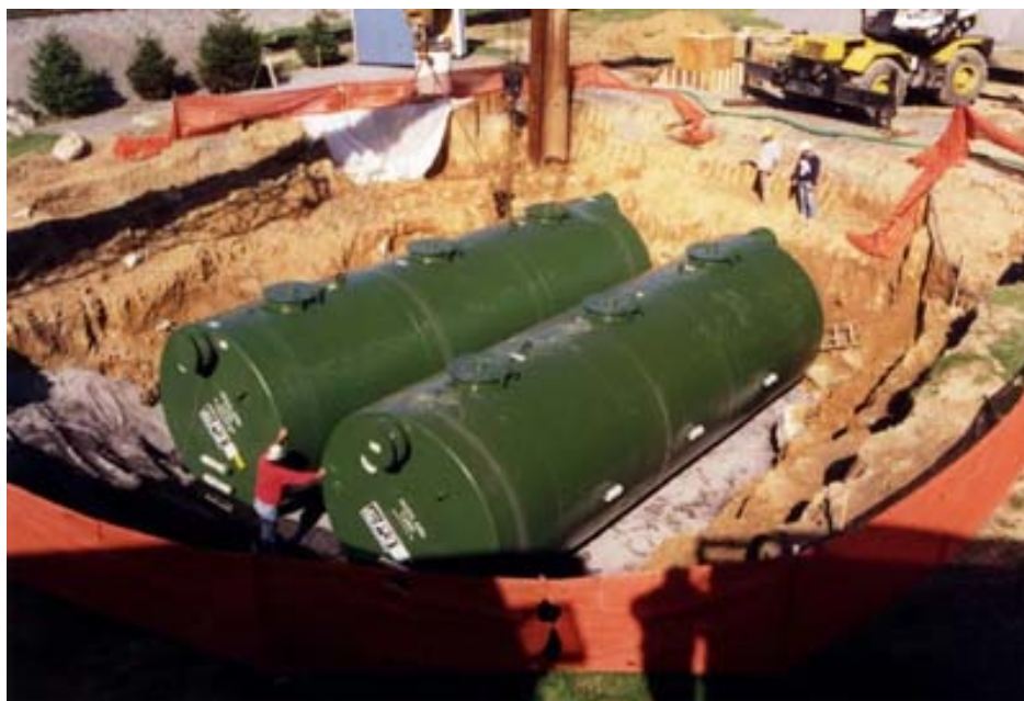
ภาพที่ 3 การวางถังน้ำมันใต้ดินในพื้นที่จริง
