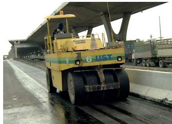
ภาพที่ 4 อุปกรณ์บดทับส่วนผสมแอสฟัลต์คอนกรีตโดยวิธีซูเปอร์เพฟ
