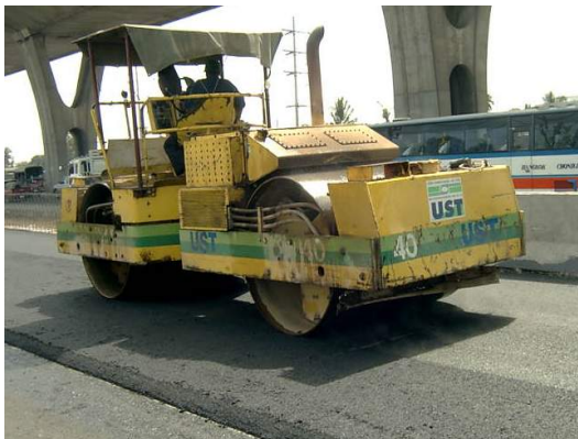
ภาพที่ 4 อุปกรณ์บดทับส่วนผสมแอสฟัลต์คอนกรีตโดยวิธีซูเปอร์เพฟ
