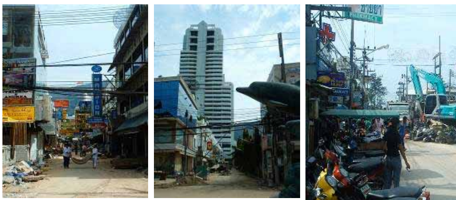
ภาพที่ 19 สภาพความเสียหายของถนนสายย่อยและซอยที่เชื่อมต่อระหว่างถนนทวิงส์ และถนนราษฎร์อุทิศ 200 ปี
