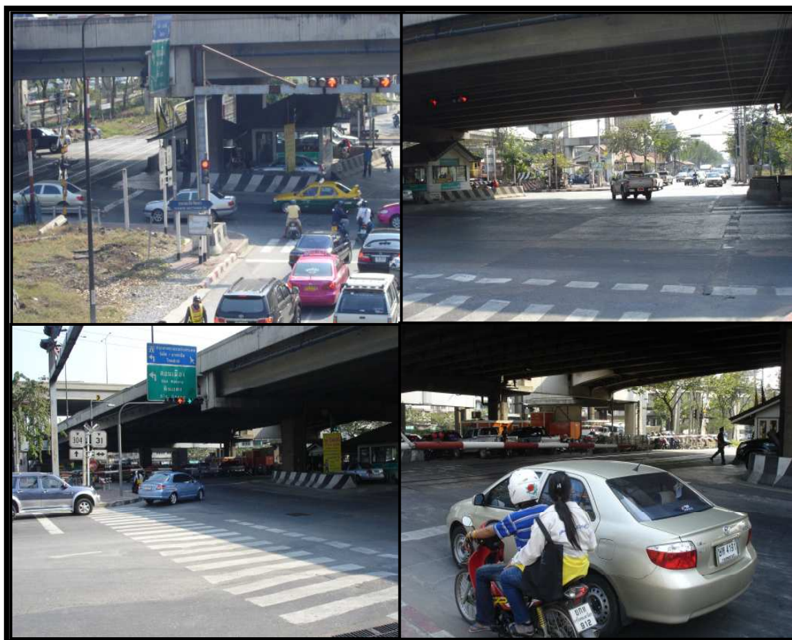
ภาพที่ 10 แสดงบริเวณทางแยกจุดตัดทางรถไฟ บริเวณทางแยกหลักสี่
