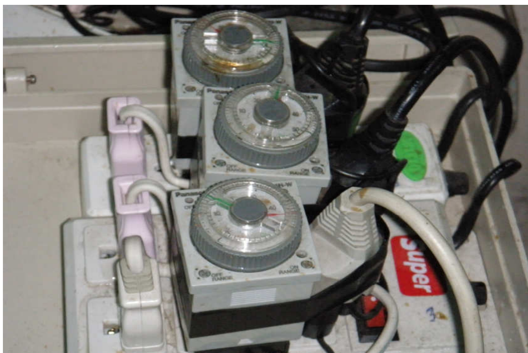
ภาพผนวกที่ ค5 ชุด Timer ควบคุมการทำงานของปั๊ม
