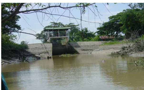
ภาพที่ 57 ภาพประตูระบายน้ำเหนือปากคลองเชื่อมต่อแม่น้ำซึ่งมีไว้เพื่อใช้ประโยชน์ในการป้องกันการรुक้าของน้ำทะเลในช่วงฤดูแล้ง
