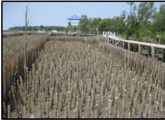
ภาพที่ 2-4 การปักไม้ไผ่ตงชะลอคลิ้นและปลูกป่าชายเลนบริเวณศูนย์อนุรักษ์ทรัพยากรทางทะเลและชายฝั่งที่ 2 (สมุทรสาคร) ตำบลโคกขาม อำเภอเมือง จังหวัดสมุทรสาคร ที่มา : กรมทรัพยากรทางทะเลและชายฝั่ง, 2553
