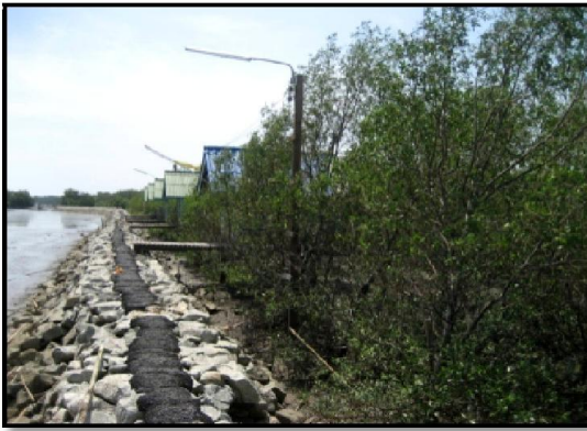
ภาพที่ 2-11 กำแพงป้องกันคลื่นใกล้ชายฝั่งแบบหินทิ้งหรือหินเรียงฐานรากเข็มสน บริเวณ บ้านสีลังตำบลสองคลอง อำเภอบางปะกง จังหวัดฉะเชิงเทรา
