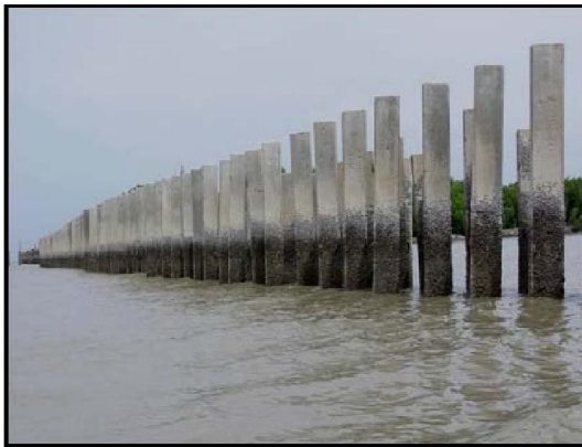
ภาพที่ 2-15 แนวปักเสาเข็มคอนกรีตหล่อแบบสี่เหลี่ยมของวัดขุนสมุทรราชต่อด้วยคอนกรีตหล่อแบบสามเหลี่ยม 49A2 ของจุฬาลงกรณ์มหาวิทยาลัย บริเวณวัดขุนสมุทรราช ตำบลแหลมฟ้า อำเภอพระสมุทรเจดีย์ จังหวัดสมุทรปราการ ที่มา : ดร.วรศักดิ์ พ่วงเจริญ สำนักงานนโยบายและแผนทรัพยากรธรรมชาติและสิ่งแวดล้อม ตารางที่ 2-15 ข้อดีและข้อเสียของการทำเสาคอนกรีตหรือเสาเข็ม
