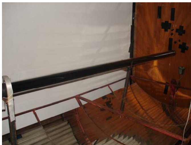
ภาพที่ 5 ท่อสุญญากาศใช้เป็นท่อรับแสงในระบบและการติดตั้ง
