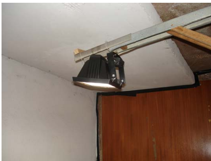
ภาพที่ 3 การติดตั้งเครื่องกำเนิดแสง
