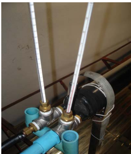
ภาพที่ 13 การติดตั้งเทอร์โมมิเตอร์กับท่อน้ำ
