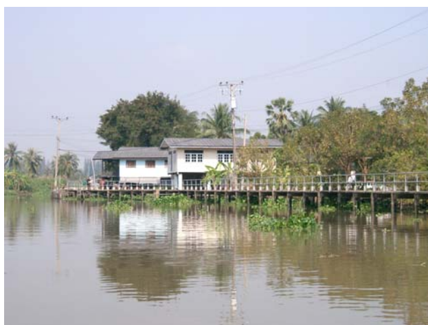
ภาพที่ 3.10 ทางเดินคอนกรีตริมน้ำอาจทำให้เสียความเป็นส่วนตัวและมีปัญหาขโมย ที่มา: มูลนิธิสิ่งแวดล้อมไทย (5 มกราคม 2549)
