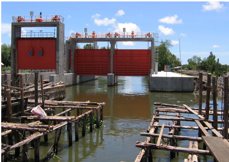
ภาพผนวกที่ ก12 การก่อสร้างประตูเรือสัญจรคลองขุนราชพินิจไภาพที่ 1
