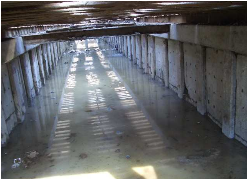
ภาพผนวกที่ ก18 การก่อสร้างเขื่อนค.ส.ล. ชนิดคาดท้องคลอง บริเวณคลองเหมือนโพธิ์ภาพที่ 1
