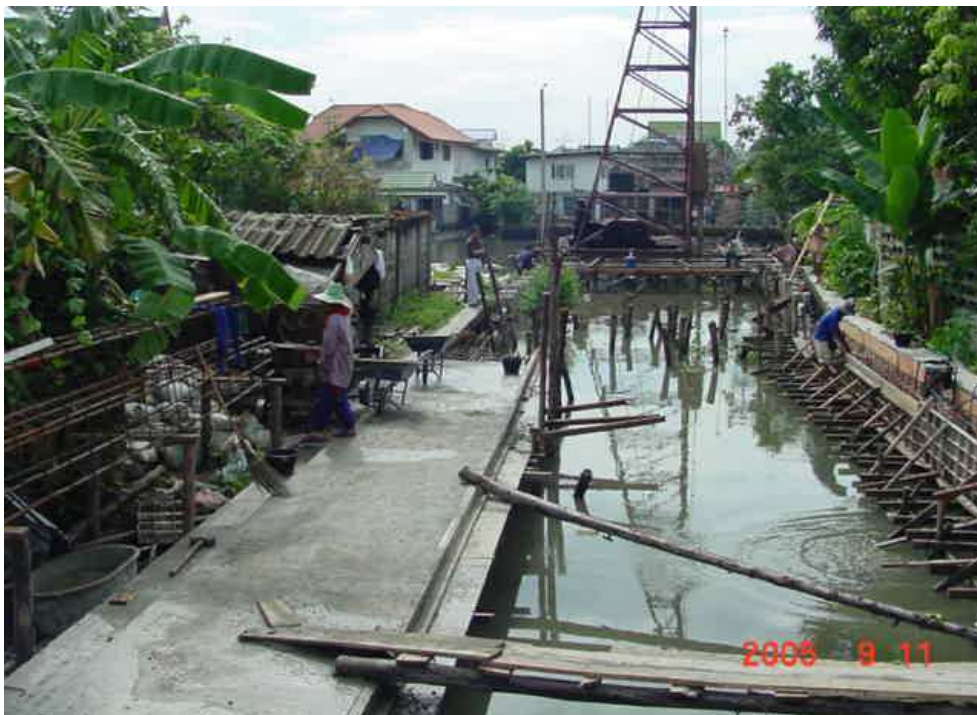
ภาพผนวกที่ ก9 การก่อสร้างประตูระบายน้ำคลองตาแผลง (ระหว่างการก่อสร้าง)
