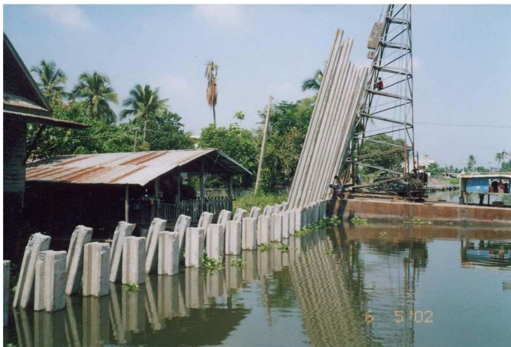
ภาพผนวกที่ ก15 การก่อสร้างเขื่อนค.ส.ถ. ชนิดสมอยึดด้านหลัง ริมแม่น้ำเจ้าพระยา
