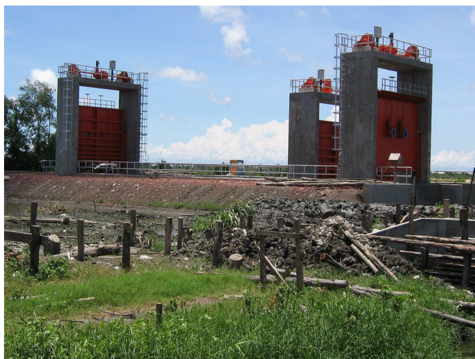
ภาพผนวกที่ ก13 การก่อสร้างประตูเรือสัญจรคลองขุนราชพินิจไภาพที่ 2
