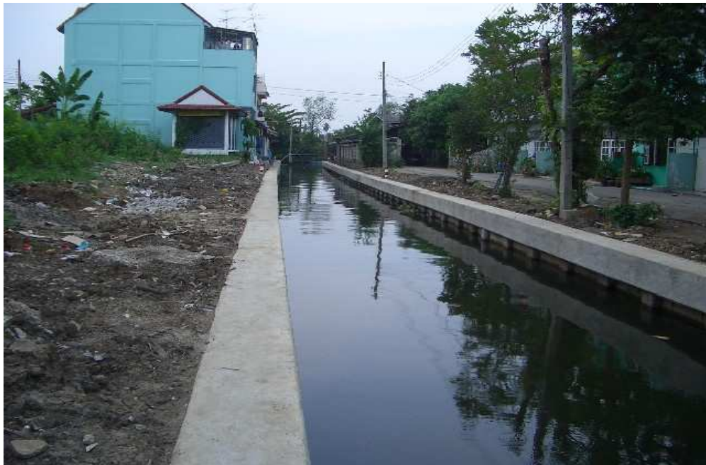
ภาพผนวกที่ ก19 การก่อสร้างเขื่อนค.ส.ล. ชนิดคาดท้องคลอง บริเวณคลองเหมือนโพธิ์ภาพที่ 2
