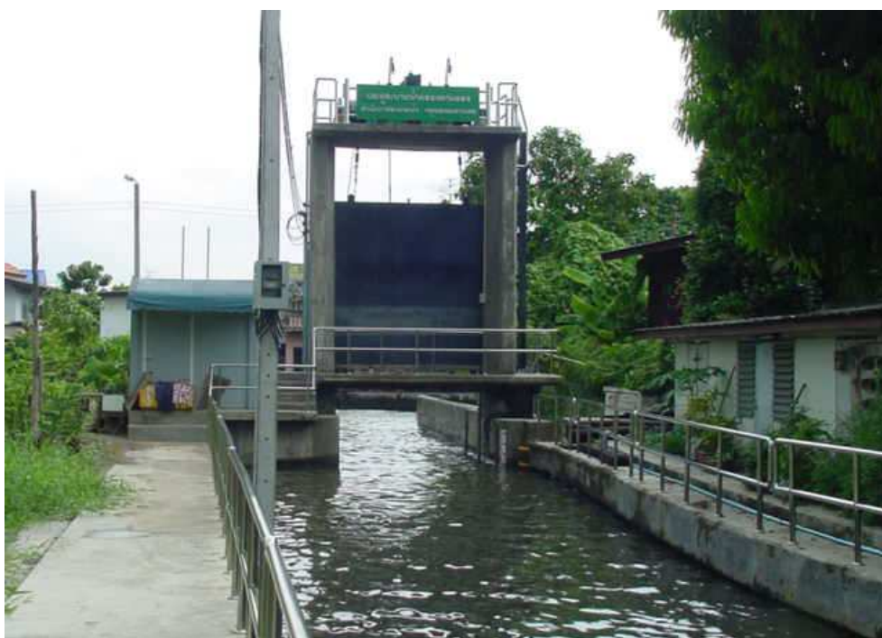
ภาพผนวกที่ ก10 การก่อสร้างประตูระบายน้ำคลองตาแผลง (ก่อสร้างแล้วเสร็จ)
