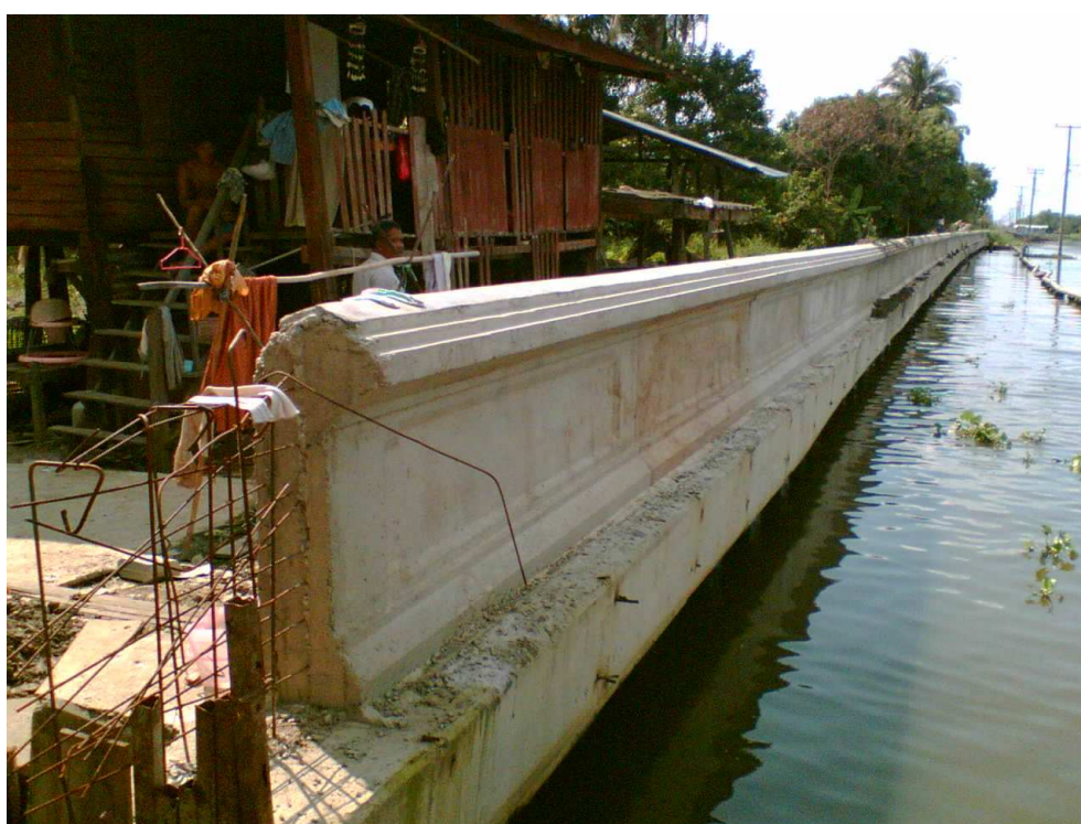
ภาพผนวกที่ ก16 การก่อสร้างเขื่อนค.ส.ถ. ชนิดสมอยึดด้านหลัง ริมคลองมหาสวัสดิ์
