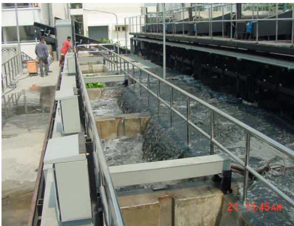
ภาพผนวกที่ ก7 การก่อสร้างสถานีสูบน้ำคลองสนามชัย (ก่อสร้างแล้วเสร็จ)
