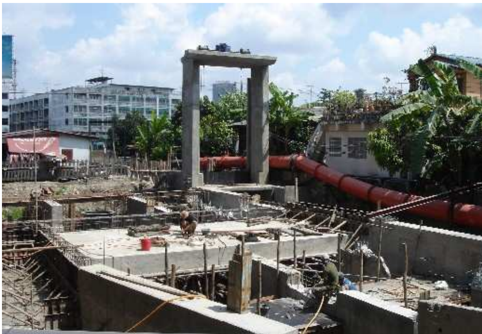
ภาพผนวกที่ ก6 การก่อสร้างสถานีสูบน้ำคลองวัดไก่อเตี้ย (ระหว่างการก่อสร้าง)
