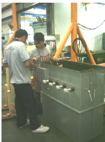
ภาพที่ 5 แสดงหน่วยผลิต Tanking ของหม้อแปลงไฟฟ้าแรงสูง
