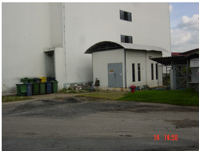
ภาพที่ 34 ห้องเครื่องสูบน้ำดับเพลิง
