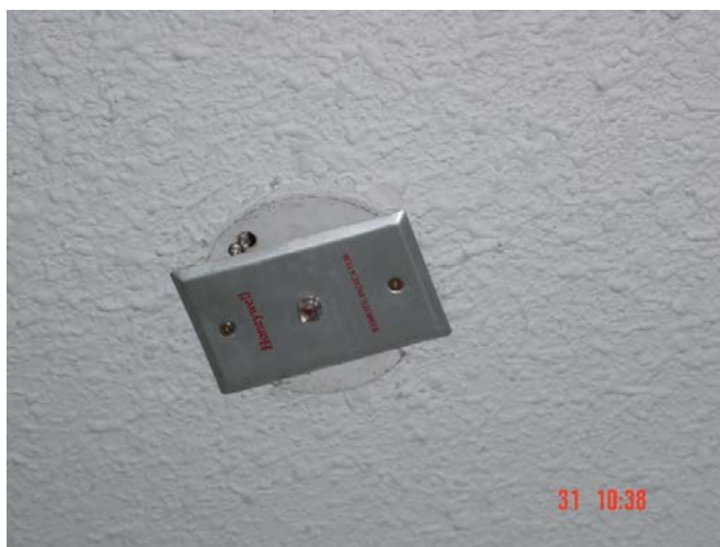
ภาพที่ 65 อุปกรณ์แจ้งเตือนระยะไกล (Remote Lamp)
