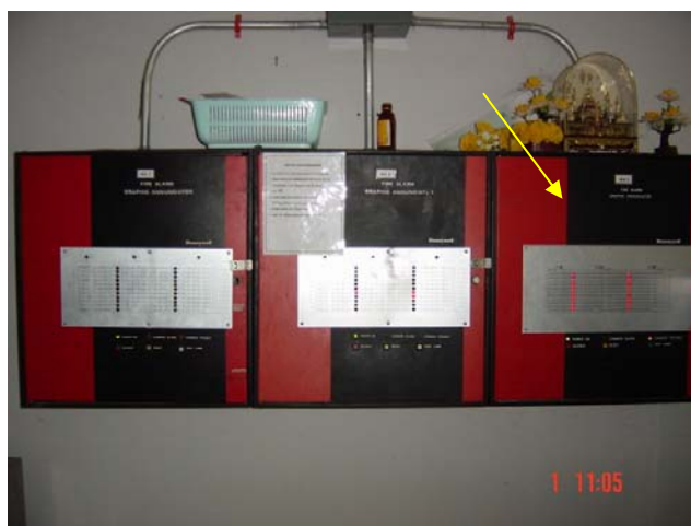
ภาพที่ 60 แผงแสดงผลของระบบแจ้งเตือนอัคคีภัย
