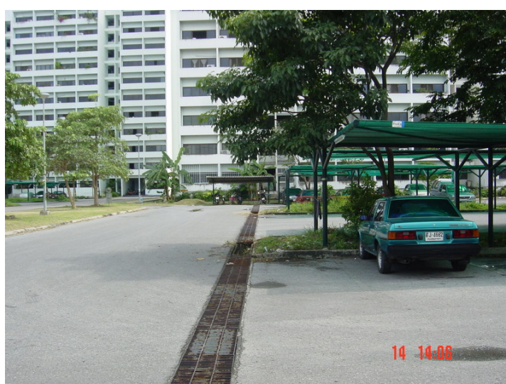
ภาพที่ 15 ท่อระบายน้ำจากอาคาร
