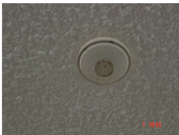
ภาพที่ 64 อุปกรณ์ตรวจจับความร้อน
