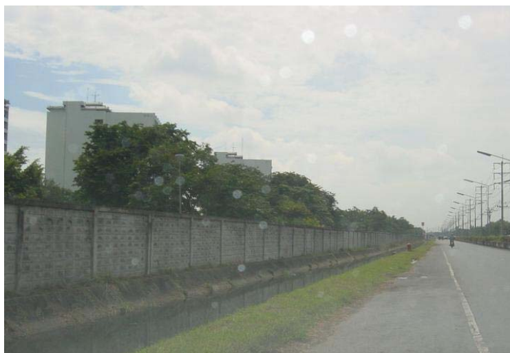
ภาพที่ 16 คูระบายน้ำเลียบนถนนเดชะตุ่งคะ
