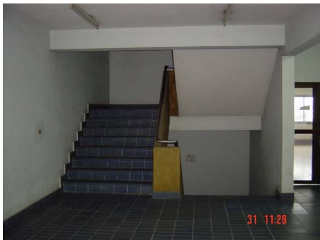
ภาพที่ 77 บันไดขึ้น-ลงอาคาร
