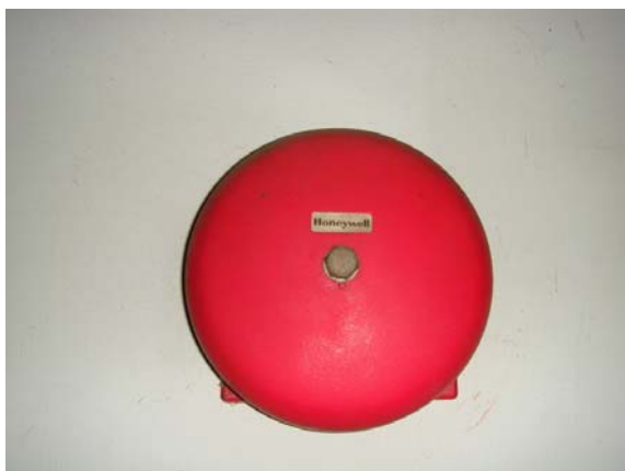
ภาพที่ 66 สัญญาณแจ้งเตือนเพลิงไหม้ (Alarm Bell)
