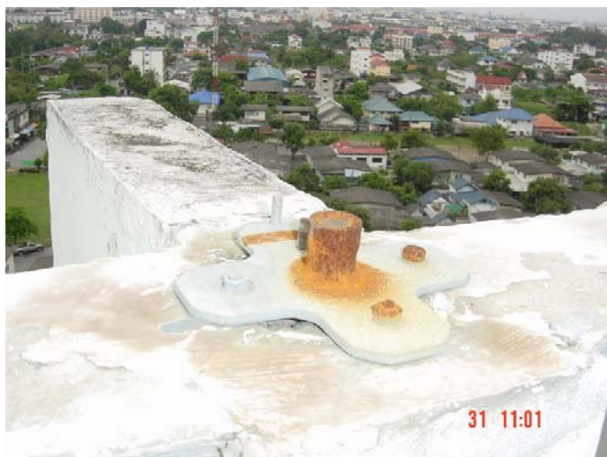
ภาพที่ 69 สภาพเสาหล่อฟ้าที่ถูกตัด
