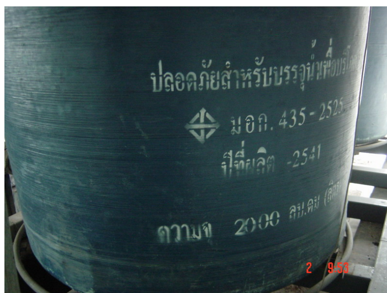
ภาพที่ 10 ถังเก็บน้ำบนดาดฟ้าของอาคาร
