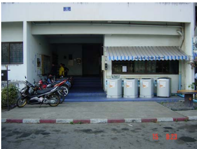
ภาพที่ 74 ทางเข้า-ทางออกด้านหน้าของอาคาร
