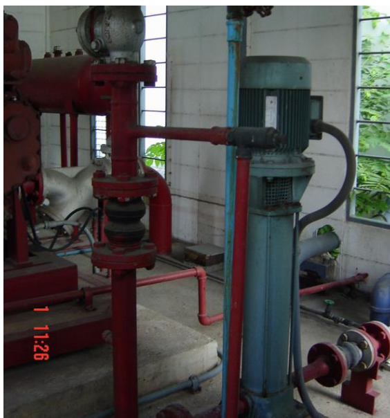
ภาพที่ 40 เครื่องสูบน้ำรักษาแรงดัน
