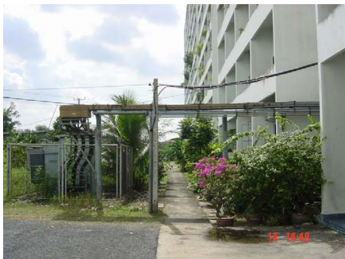
ภาพที่ 25 การเดินสายไฟฟ้าเข้าอาคาร
