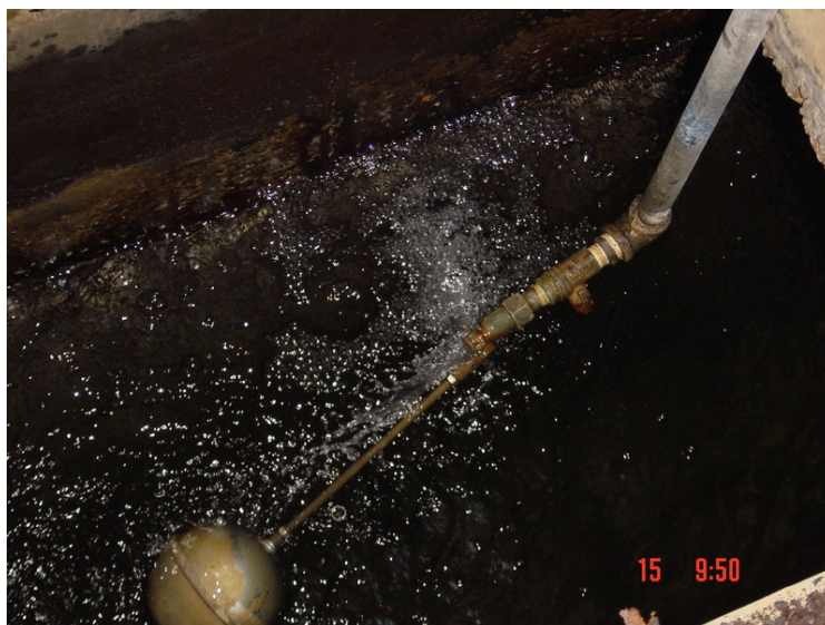
ภาพที่ 8 ถังเก็บน้ำใต้ดิน
