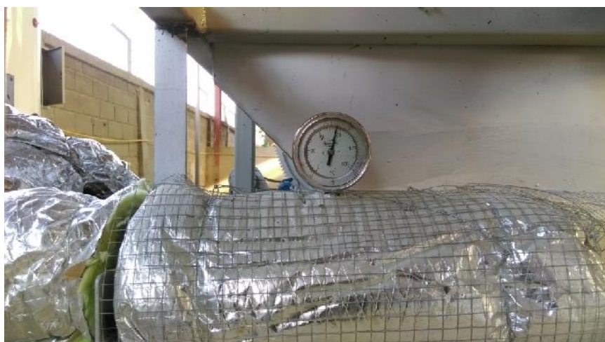
ภาพที่ 4.17 เครื่องมือวัดอุณหภูมิของลมร้อนที่ผ่านการแลกเปลี่ยนความร้อน
