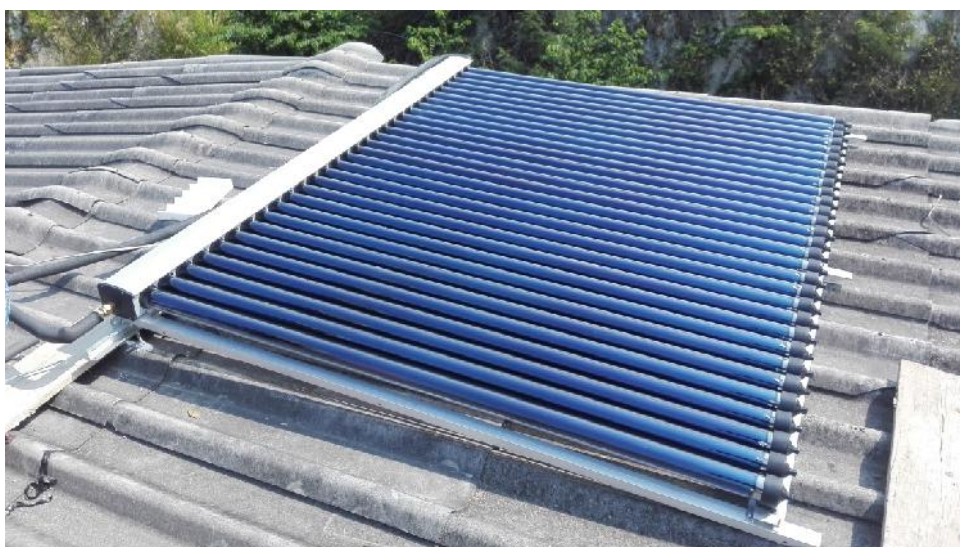
ภาพที่ 3.19 การติดตั้งชุดแผงรับความร้อนชนิดหลอดสุญญากาศบนหลังคาโรงงาน
