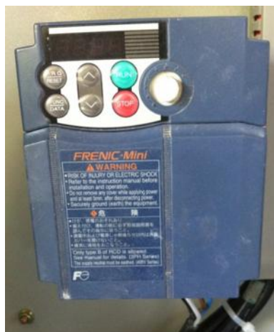
ภาพที่ 3.11 อุปกรณ์ปรับความเร็วของมอเตอร์
