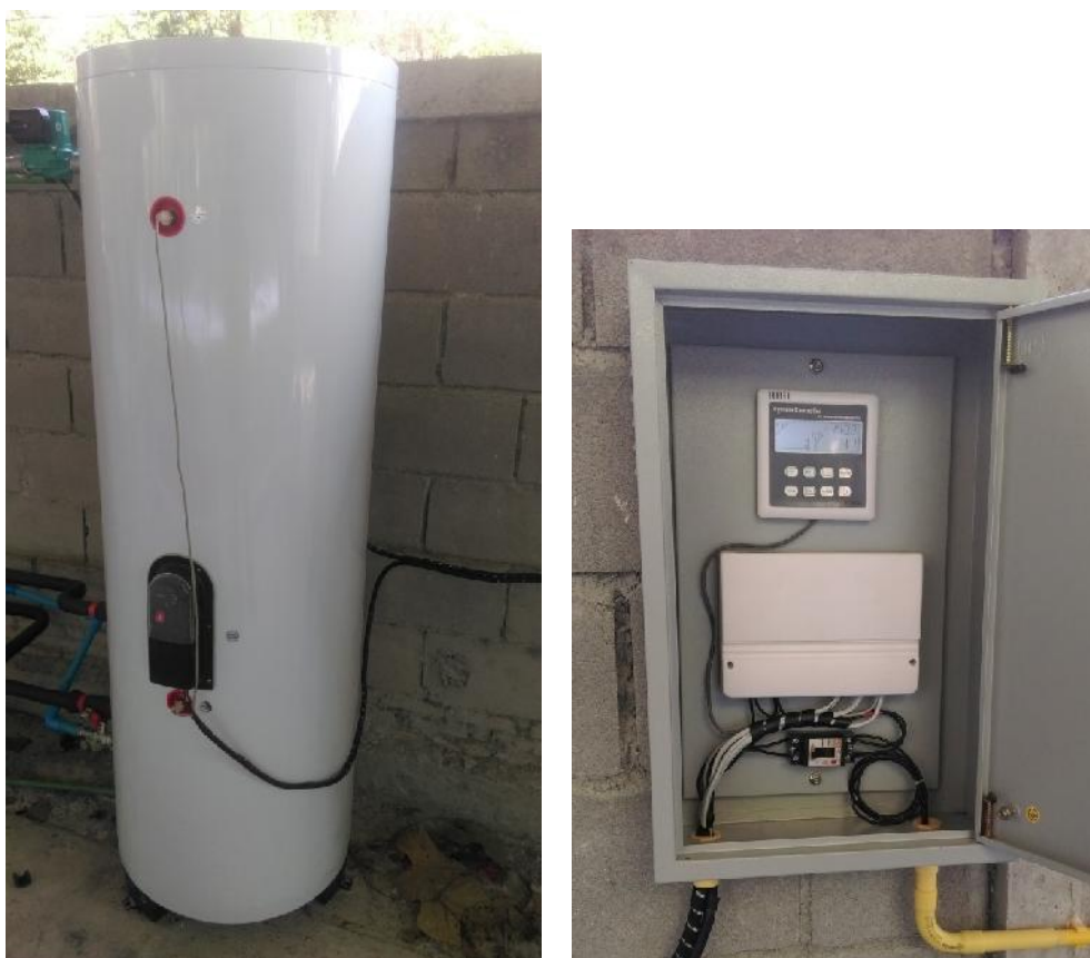
ภาพที่ 3.21 การติดตั้งถังกักเก็บน้ำร้อนขนาด 300 ลิตร และอุปกรณ์ควบคุมระบบการทำงาน
