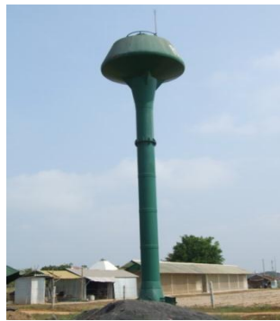
เชื่อมต่อระบบการใช้น้ำจากแท็งก์เก็บน้ำใหญ่
