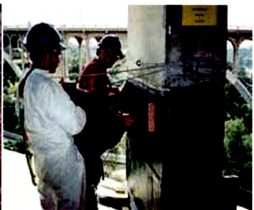
รูปที่ ๒.๒๓ คาร์บอนไฟเบอร์เสริมแรงพอลิเมอร์ในการประยุกต์ใช้ในงานคอนกรีตเสริมเหล็ก
