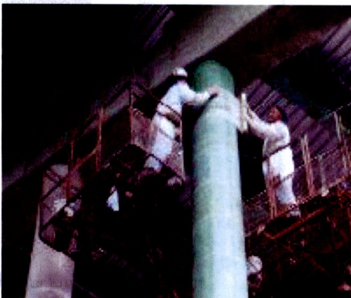
รูปที่ ๒.๒๓ คาร์บอนไฟเบอร์เสริมแรงพอลิเมอร์ในการประยุกต์ใช้ในงานคอนกรีตเสริมเหล็ก
