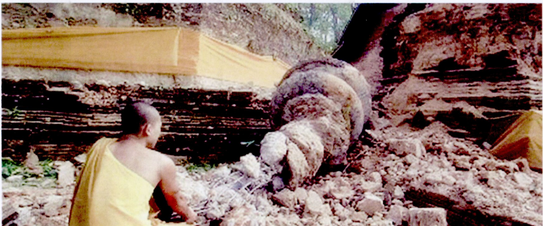
รูปที่ ๑.๒ การพังทลายของโบราณสถานประเภทเจดีย์ ในจังหวัดเชียงราย จากเหตุการณ์แผ่นดินไหวขนาด ๖.๘ ริกเตอร์ในพม่า ณ วันที่ ๒๔ มีนาคม ๒๕๕๔
