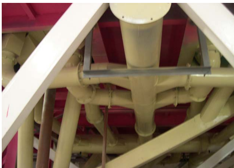
ภาพที่ 46 ท่อลมซึ่งใช้ในการส่งลมเข้าสู่กระบวนการ
