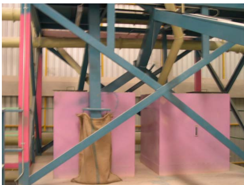
ภาพที่ 44 กระบวนการคัดแยกสิ่งเจือปนโดยแยกจากขนาด
