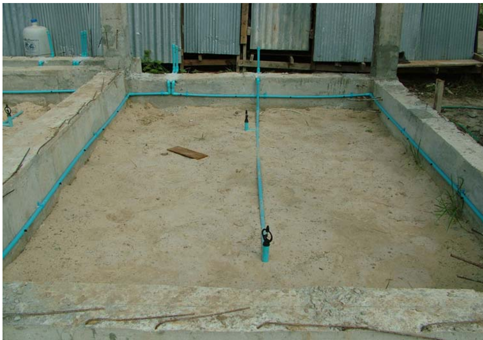
ภาพที่ 18 ลักษณะการเดินท่อในงานจริง
