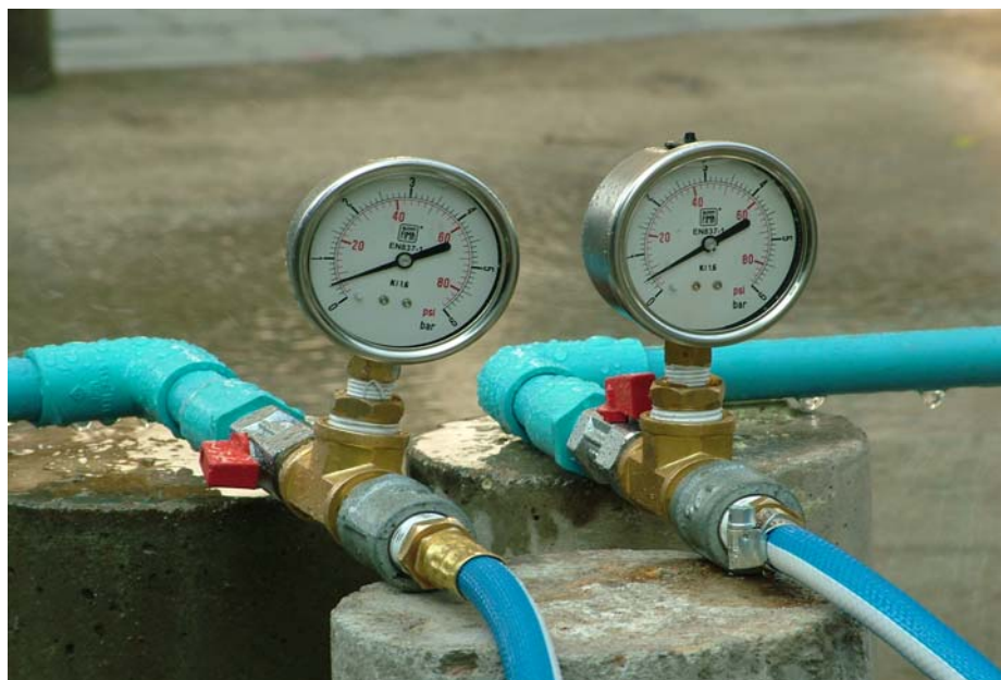
ภาพที่ 17 แสดงการติดตั้งชุดมาตรวัดความดันช่วงเข้าท่อ
