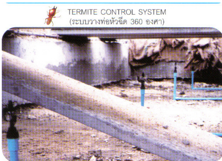
ภาพที่ 9 แสดงการติดตั้งระบบ TERMITE CONTROL SYSTEM ที่มา: สุทธิยา (2547)
