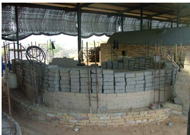
ภาพที่ 10 การก่อสร้างโรงเรือนและการก่อสร้างเตาอิฐตามแบบแปลน ที่มา: พุฒินันท์ (2547)
