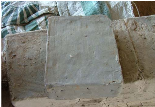
อิฐดินเหนียวที่ใช้ในการก่อสร้างเตาอิฐตะ
