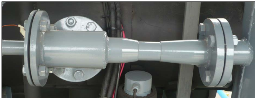
รูปที่ 3.3 หัวฉีดลดความดัน (Ejector)
