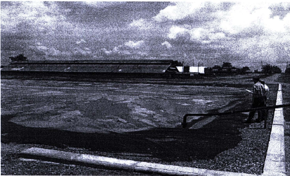
ภาพ 4 การบำบัดน้ำเสียจากฟาร์มเลี้ยงสุกรโดยใช้ระบบบ่อหมักแบบพลาสติกคลุมบ่อ ที่มา. จาก การบำบัดน้ำมูลสุกรแบบไร้อากาศ (หน้า 17), โดย มูลนิธิพลังงานเพื่อ- สิ่งแวดล้อม, 2550, กรุงเทพฯ: ผู้แต่ง.
